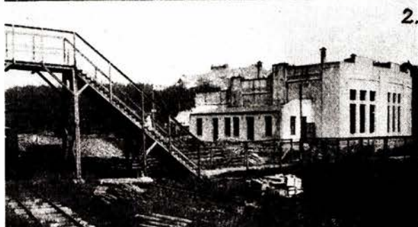
1. Lokomotivverksted ved Vaulen. 2. Lokomotivstall for 8 lokomotiver.
