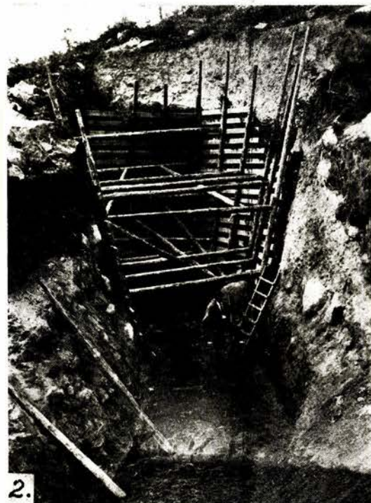
1. Vestre innslag for den 3000 m lange Trondåstunnel. 2. En brysom bekketunnel, innløp fra Konglevollmyren.
