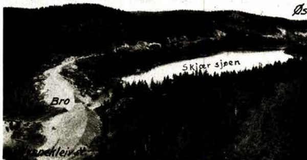
1. Herefoss stasjonsbygning og bakenforliggende lager av ballastpukk. 2. Sørlandsbanen seet østover fra Hynnekleiv st. langs Skjærsjøen. I forgrunnen åpning for bro over Skjærsjøelven.
