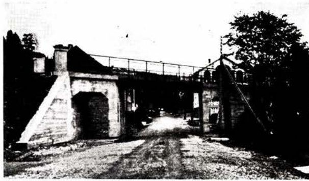
Fig. 3. Skjev undergang med 2 sidespenn av jernbetong ved km 0,8 for hovedveien til Sogn (Strandveien).
