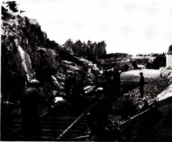
Sørlandsbanen Ø.: Skinnelegning ved Bjorvatn stasjon.
