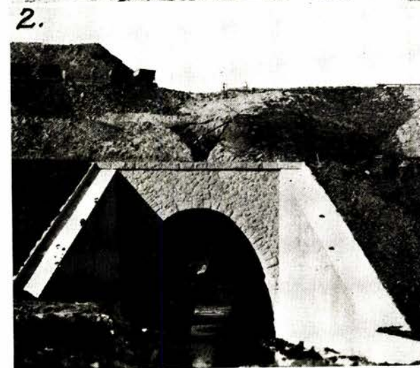
1. Portal ved Forsjordlia tunnel. 2. Bro over Fiskumelv , pel 9963 +9, august 1934.
