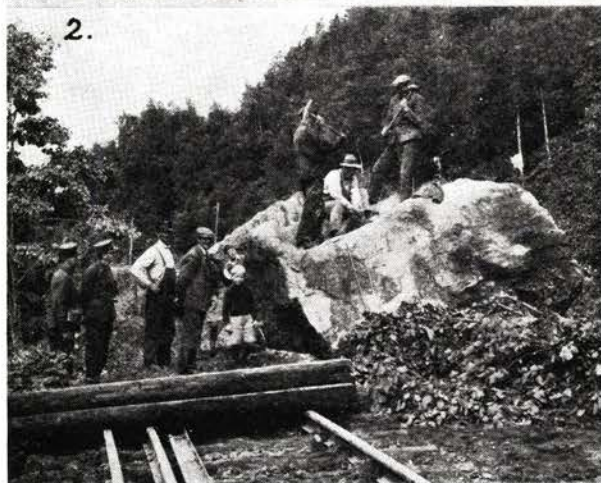
1. Skredets omfang. 2. Stor sten i jernbanelinjen.
