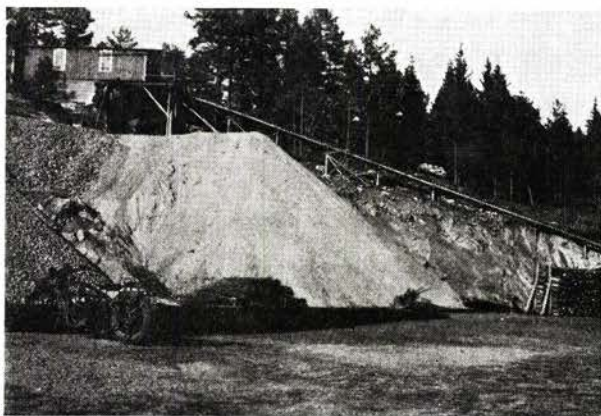
Fig. 1. Sørlandsbanen Ø. Pukkverk ved Vegårshei.
