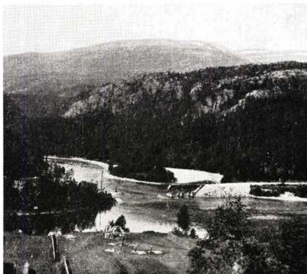
Fig. 7. Nordlandsbanen N. Fundamentering for bro over Eiteråga.
