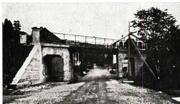
Fig. 8. Voss—Eidebanen. Skjev undergang med 2 sidespenn av jernbetong på Vossevangen (km 0,8) for hovedveien til Sogn (Strandveien).
