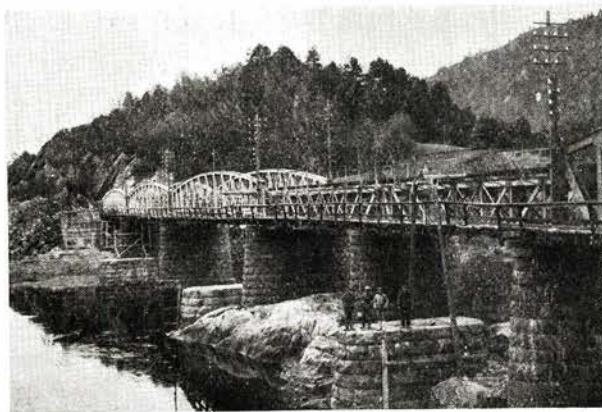
Fig. 5. Ombygning Kristiansand—Grovane. Bro over Otra ved Kvarstein. Kår for ny bro med spenn 45, 32, 45 og 32 m bygges ved siden av nuværende bro for Setesdalsbanen.
