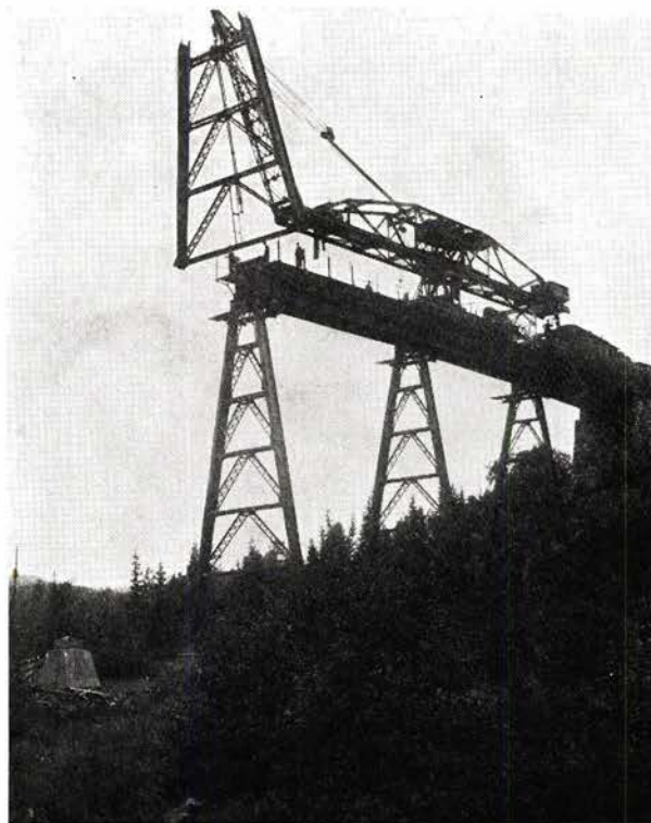
Fig. 2. Sørlandsbanen Ø. Montering av Trollelven viadukt med jernbanens monteringskran. 12 spenn à 16 m. Maksimum høide ca. 25 m over dalbunnen. Ca. 410 tonn jernoverbygning leveres av Alfred Andersens mek. verksted & stperi , Larvik.
