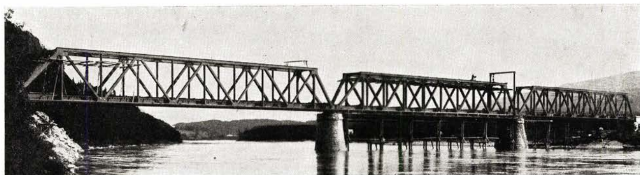
Bro over Namsen ved Bertnem (midtre spenn under montering 1932).
