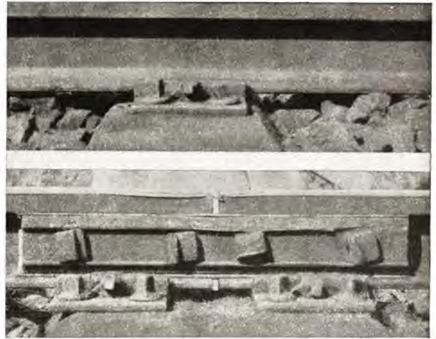
Fig. 2. Befestigelse med klemkiler. (Norsk system).
