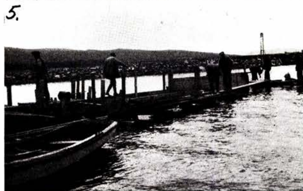
Fig. 3 Muring av senkbrønnen.
