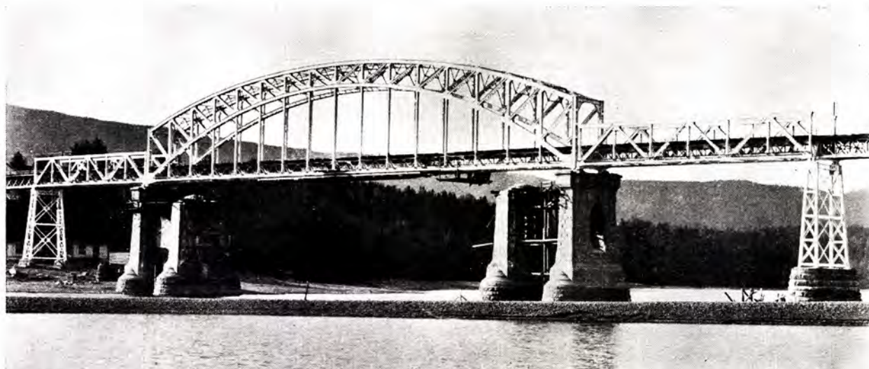
Fig. 18. \frac{8}{10} 1913. Stillaset fjernet. Rivningen av de gamle murpillarer påbegynt.
