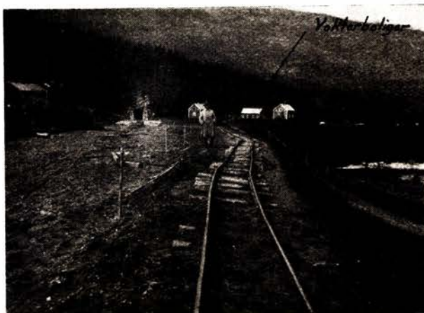
Nordlandsbanen N. Laksfors stasjon. Km 27,5 fra Mosjøen.
