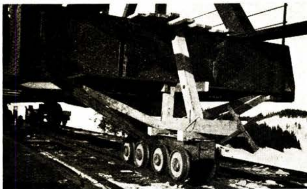
Tømmeråsfoss bro. Småtrallene under bakre endetverrbærer ved 1. utkjøring. 1. april 1931.
