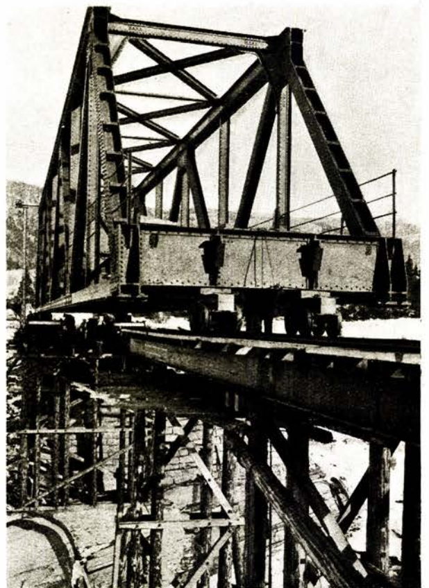
Tømmeråsfoss bro. Småtraller under 2. og 3. utkjøring. Billedet tatt under 2. utkjøring, 1. april 1931.
