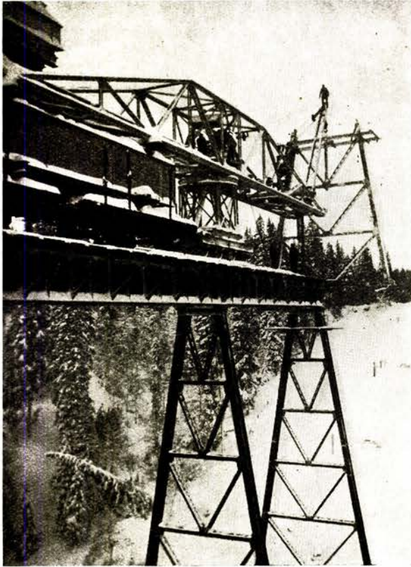
Rottesdal viadukt. Januar 1932.
