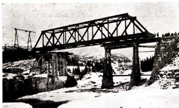
Tommerås-foss bro. 3. utkjøring. Stortrallene under bakre oplager, småtrallene foran. 1. april 1931.
