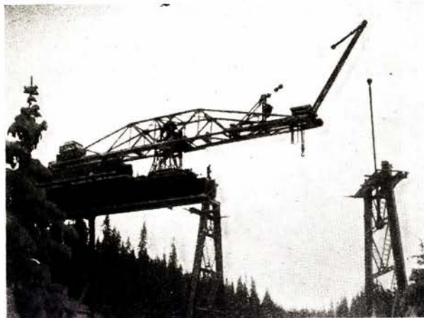
Røtredal viadukt. Km ca. 50 fra Namsos. 7 spenn å 15,3 m. Største høide fra dalbunn til S. O. ca. 28 m. Januar 1932.
