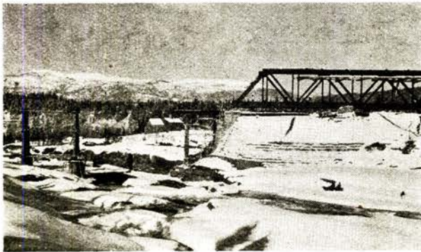
Tømmeråsfoss bro, km ca. 51 fra Namsos. 45 m th. spv. Det på land ferdigmonterte spenn for utkjøringen. Mars 1931.
