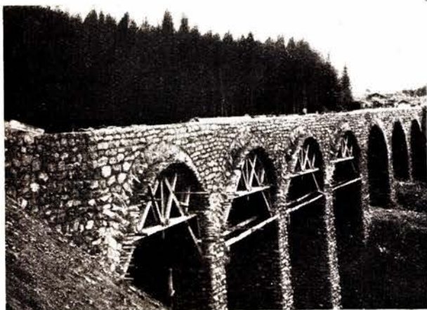
Eig. 4. Aspangbanen, Viadukt.
