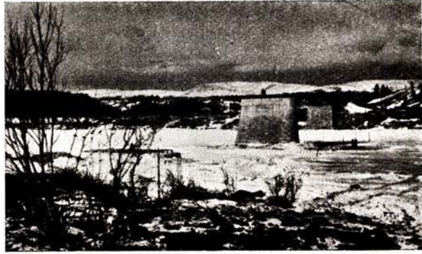
Fig. 14. Søndre pilar sees såvitt stikke over isen til venstre med armeringsjernene, nedlagt. Nordre landkar i bakgrunnen.
