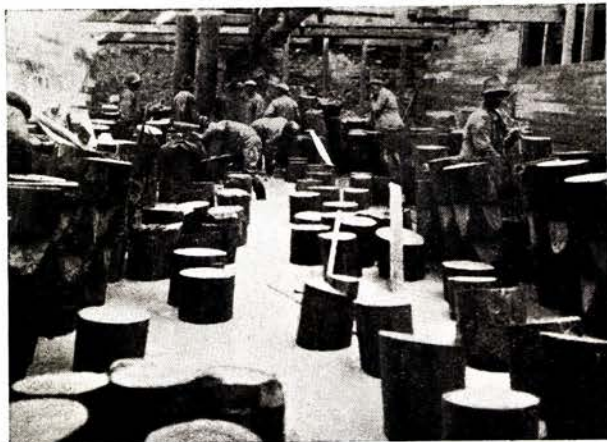
Fig. 8. Nordre pillar. Fundamentet omtrent ferdiggravet.
