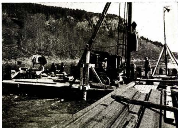
Fig. 3. Nedramning av spunnvegg for nordre pillar.
