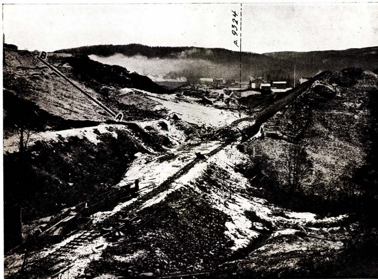
Fig. 4. Standpunkt: Skjæringskant t. v. for pel 9336. I forgrunnen sees fyll. nr. 28 dernæst skj. nr. 23 med ras. Pel 9324 er avmerket (kfr. rapport av 28. okt. 1929).
