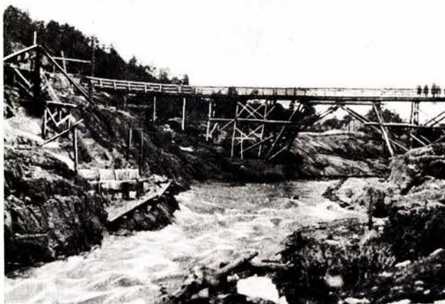
Bro over Toppdalselven ca. km 209. Et platespenn på 32,4 m th. spv. Transportbroen. Vestre landkarr påbegynt. (Aug. 1930.)
