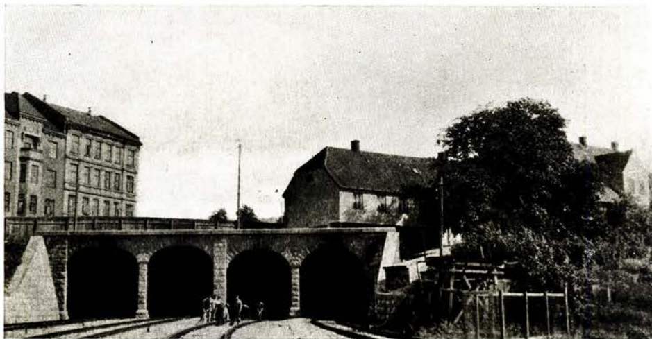
Oslo Østbanestasjons utvidelse. Nordre portal for to tunler under St. Halvards plass. Dobbeltspor til driftsbanegården i Lodalen t. v. Østfoldbanens dobbeltspor t. h.
