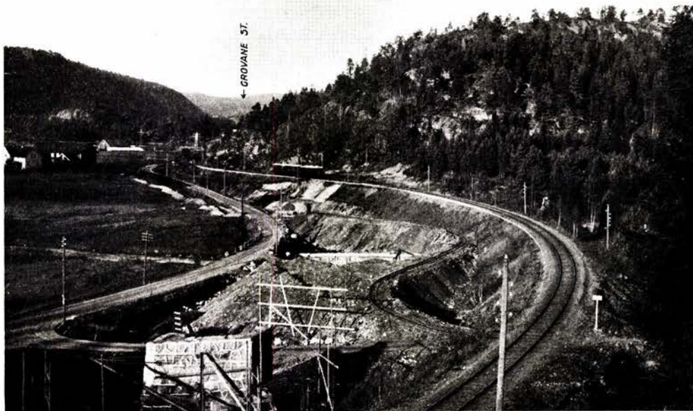
Ved Grovane st. ca. km 19 fra Kr.sand S. Mellom Setesdalsbanen (i for skarp kurve) og hovedveien en 18000 m 3 fylling for Sørlandsbanen tatt fra sideskjøring. Undergang under opførelse i forgrunnen; lang kulvert for elv midt på bildet. Hovedveien skal senere føres gjennom undergangen og efter Setesdalsbanens nedlagte linje frem til Grovane st. (i bagrunnen), hvorved nuværende plankrysning da bortfaller.
