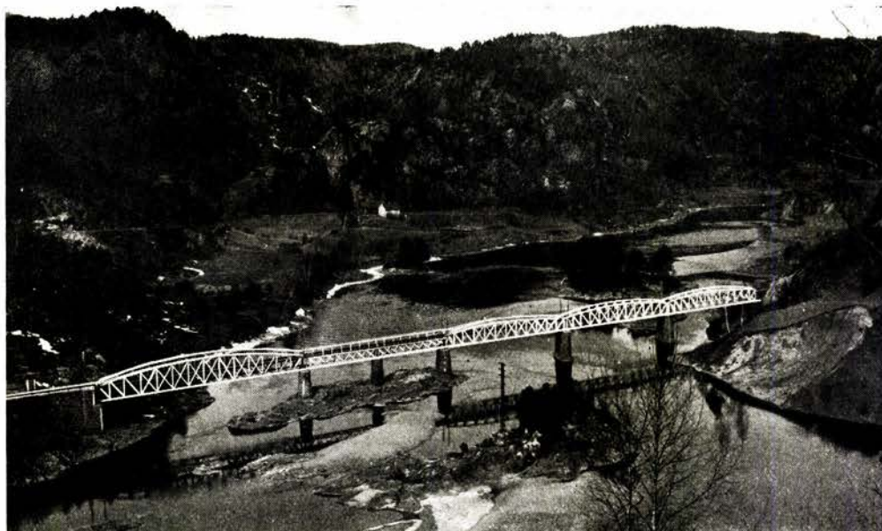
Ombygning Grovane—Kr.sand. Nuværende Kvarstein bro over Otra. Ny bro skal bygges ved siden av denne.
