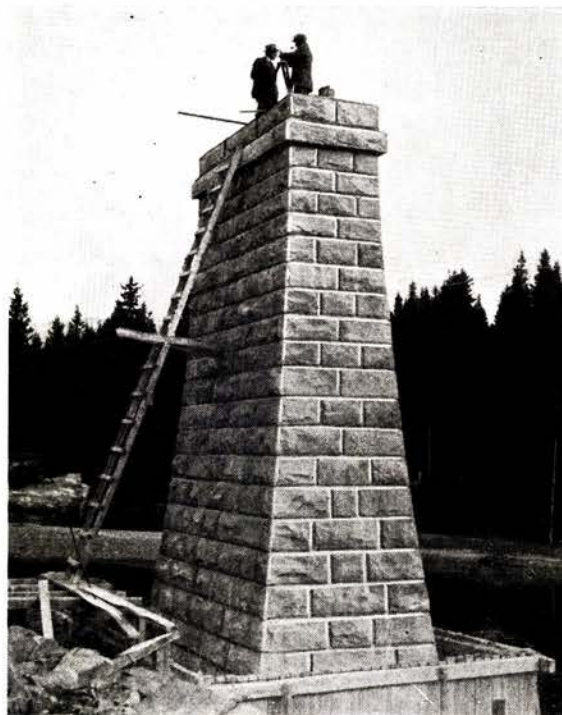
Bjøra bro. Vestre pillar. Pent murverk. Assistentingeniøren kontrollmåler.
