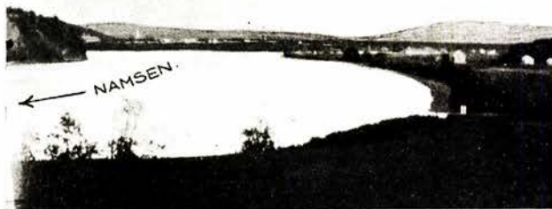
Sett fra Namsens sydside. Bergenget tunnel t. v. ca. 13 km fra Namsos. Skagesletta med Skage kirke i bakgrunnen.
