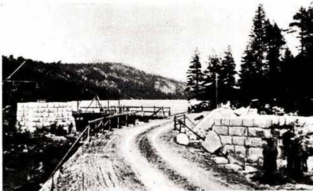
Bro over Skjærjøelven og bygdevei Arendal—Evje ca. km 200. Et platespenn på 31,6 m th. spv. (aug. 1930).
