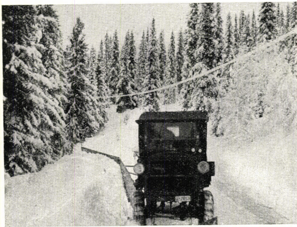
Fig. 9. Kant-rømning med sideplog.
