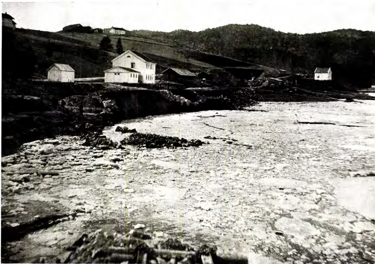
Fig. 7. Situasjon efter sprengning april 1929.
