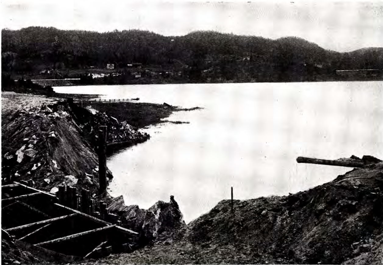
Fig. 8. Situasjon efter sprengning oktober 1929.
