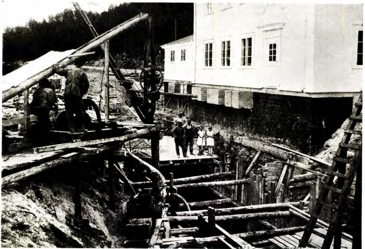
Fig. 4. Gravning for og støpning av støttemur.
