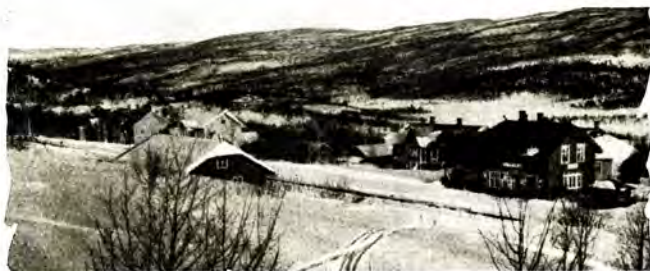
Gjeilo st. Bergensbanen.
