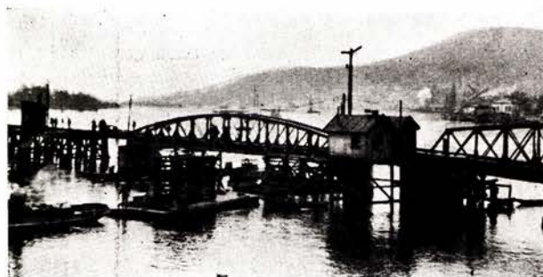
33 m spennet heves og borttransporteres, hvorved skaffes fri seil- led for skib som skal gjennom den nye broåpning.
