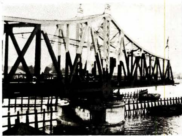
Svingbroen med teoretisk spv. 2 \times 40 m utsvinget. Selve svingspennets jernvekt er ca. 246 tonn. Den samlede vekt (trykket på pivoten) går opimot 290 tonn.
