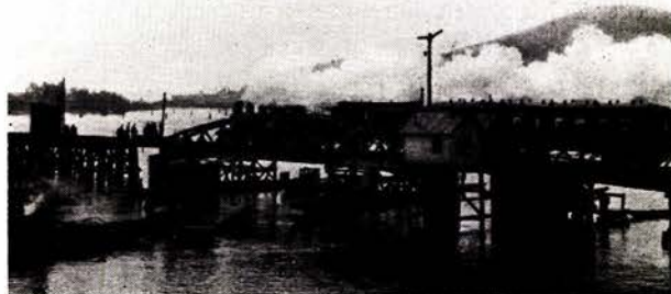
Siste tog (fra Drammen) passerer den gamle bro. — 2 pontonger til heving og bukserbåter til vekkslepning av et 33 m spenn anbragt.
