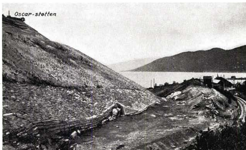
Skjæringen efter arbeidets innstilling.
