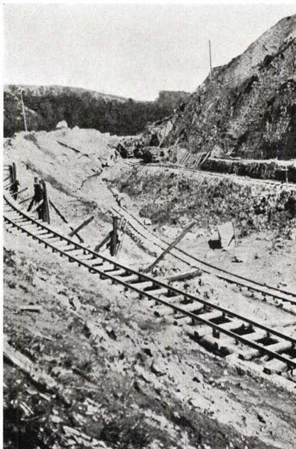
Skjæringen — 3. stadium: Lokomotivspor og gjenstående vinsjspor fra 2. stadium.
