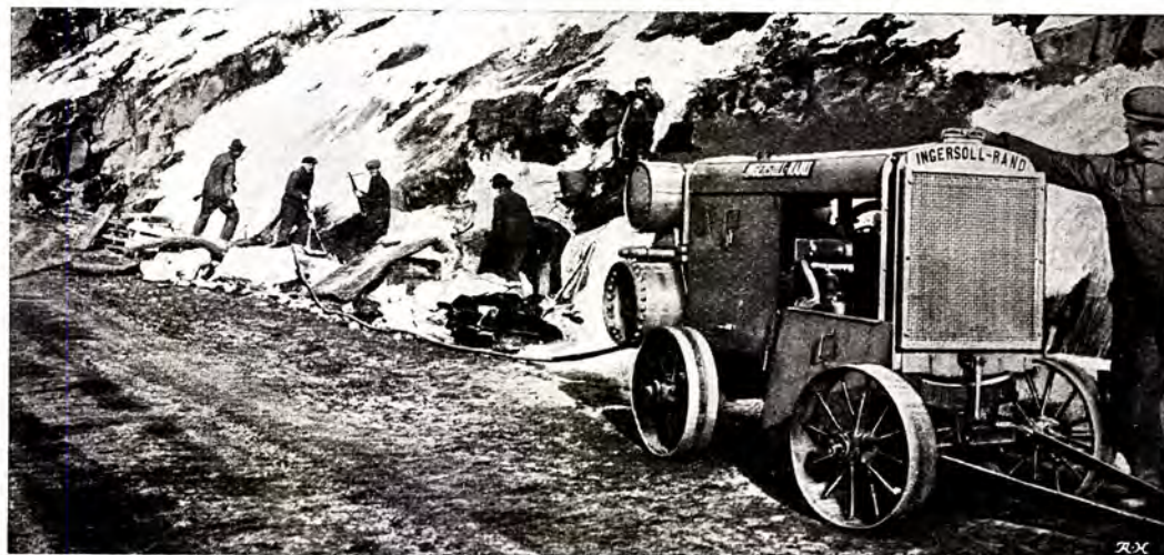
Utvidelse av Oslo Veivesens anlegg — Ljabroveien.
