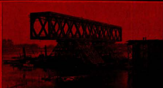
Brospenn, 105 m., 1200 tonn, for Rhiabroen ved Wessel, hvilende på trestillas satt sammen med ALLIGATOR tømmerbindere.
