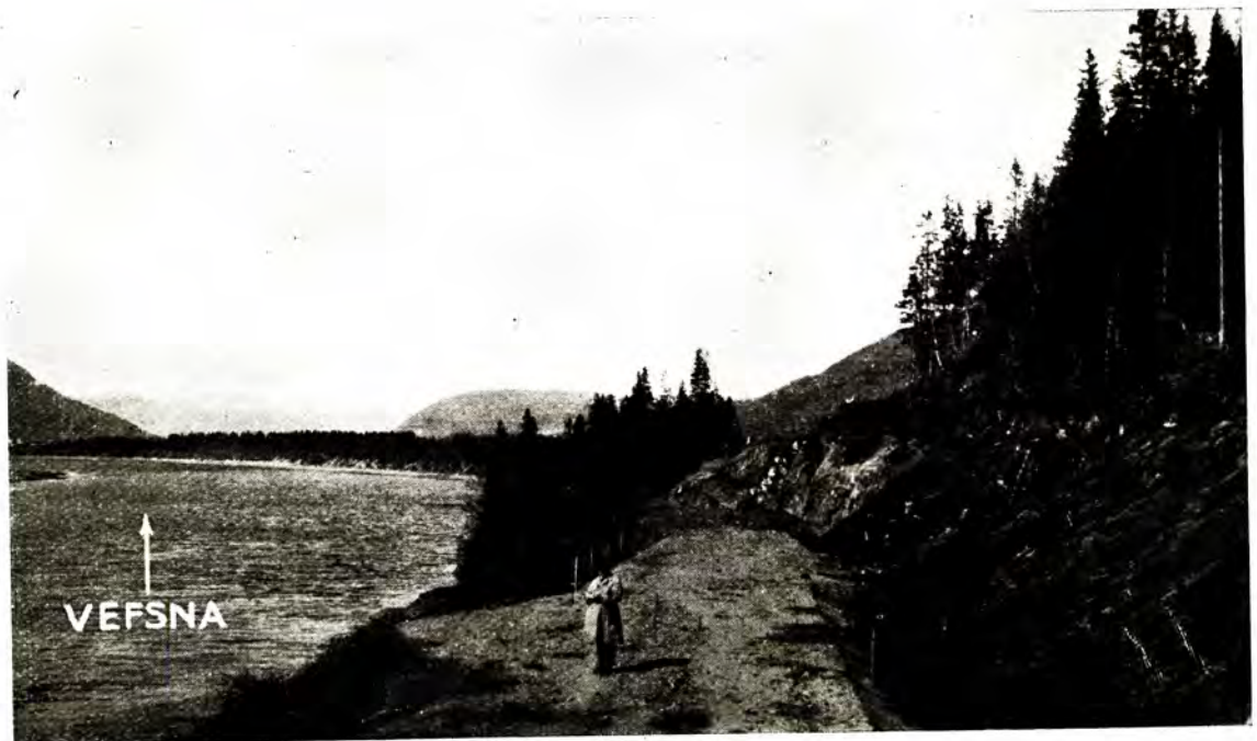
Jernbanelinjen i nærheten av Mosjøen.
