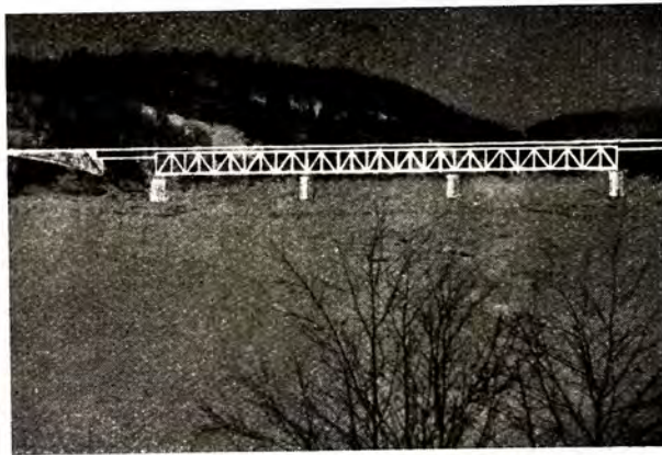
Bro over Vefsna ved Kvalfors. 3 sp. à 45 m.
