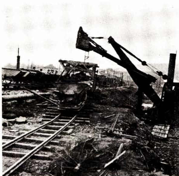
Fig. 1. Seksjon 1. Gravemaskin — 1 m 3 .
