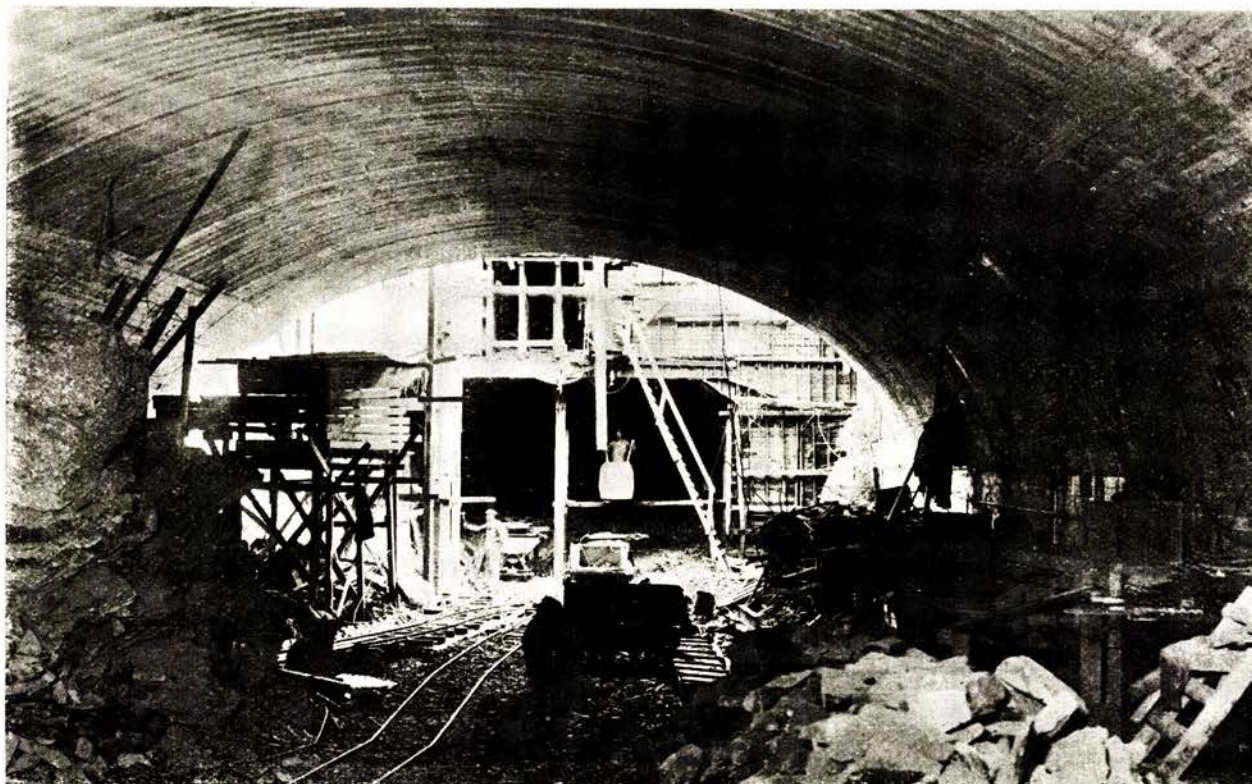
Fig. 5. Valkyrieplass stasjon, sett mot trappopgangen.
