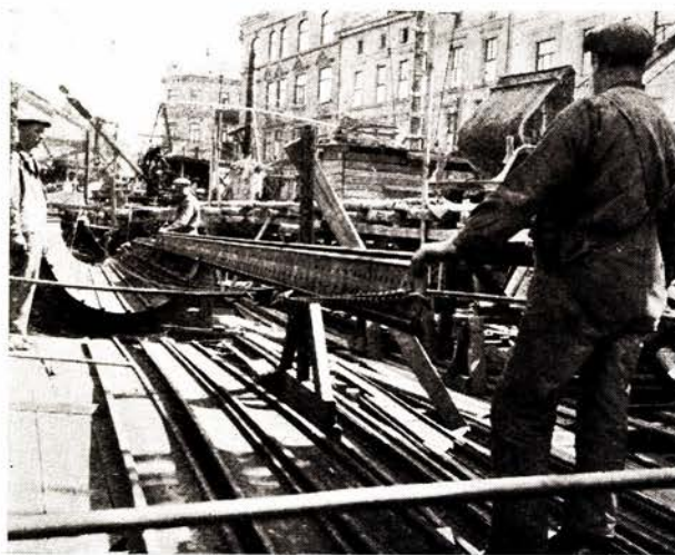
Fig. 7. Seksjon 2. Montering av jerncylindrene.
