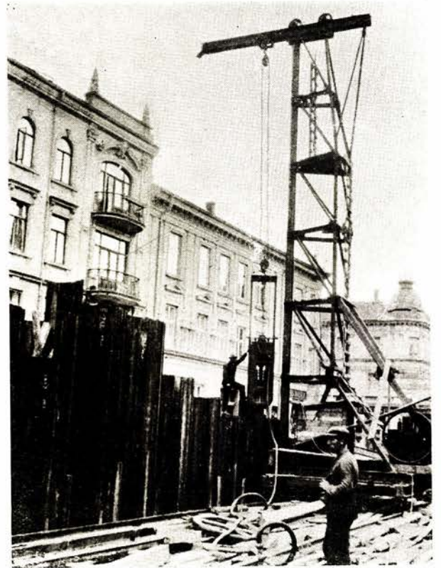
Fig. 11. Seksjon 2. Nedramning av jerncylinderne.
