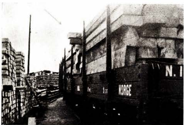
Disse tre illustrasjoner viser hvorledes svillelast blir seende ut ved fremkomsten, når endelagene ikke trekkes tett inn mot midtlaget.
