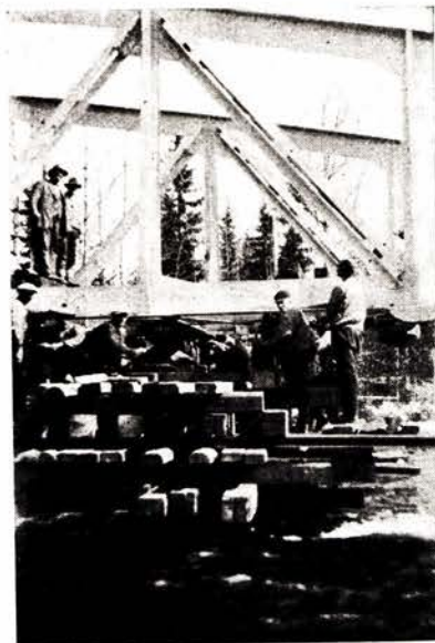
Fig. 5. Hovda bro. Kubbelaag.
