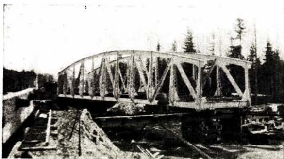
Fig. 6. Hovda bro sett fra søndre landkarr under inntrekning fredag 4/5—28 kl. 6 morgen.
