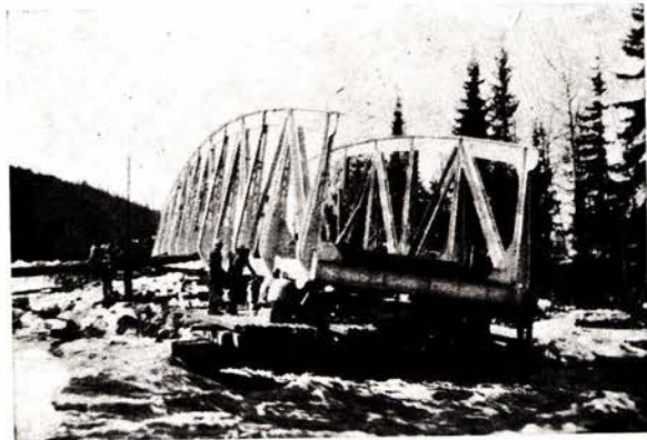
Fig. 4. Hovda bro sett fra sydøst, mandag em. 30/4—28. Kubbelaag anbragt. Opretning og løftning i full gang.
