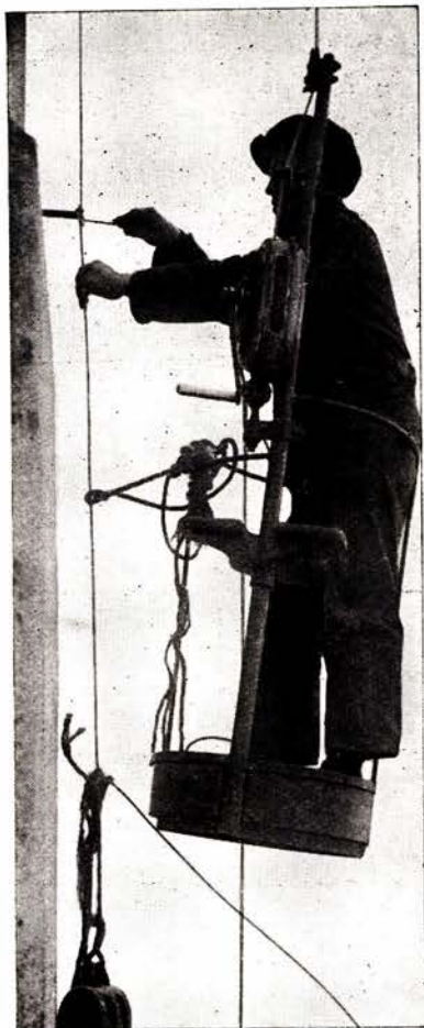
Apparat nr. 2 med gondol ved oppsetning av lynavleder på den 60 m. høie luftinntakspipe ved Norsk Hydros fabriker på Notodden.
