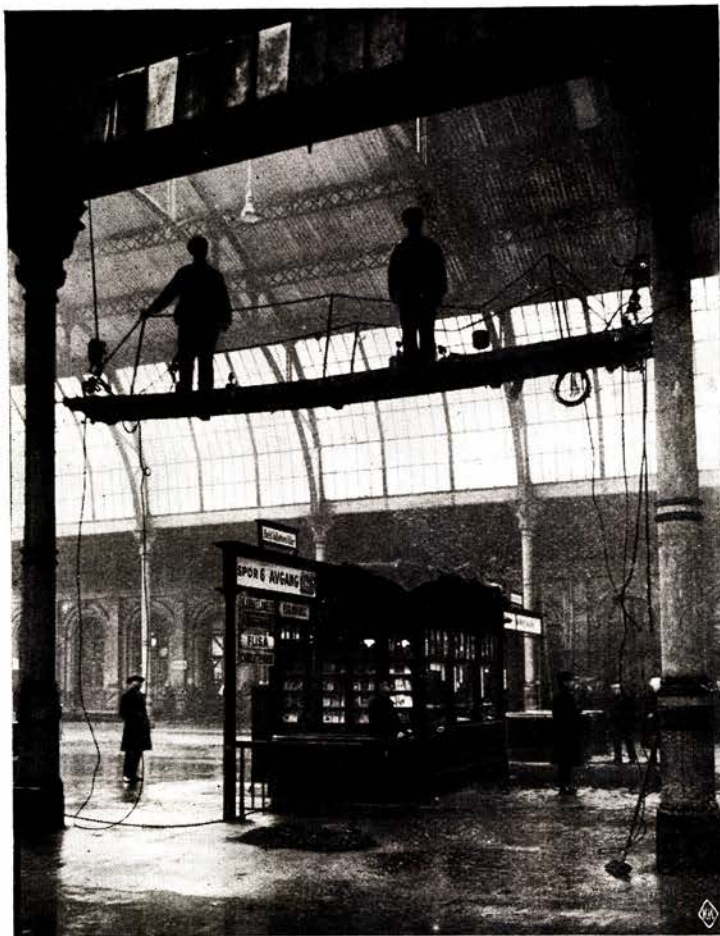
Lett stillas med 2 apparater for malning av perrongtak. Østbanestasjonen i Oslo.
