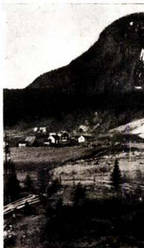
Tømmeråstunnelen. Søndre innslag.
