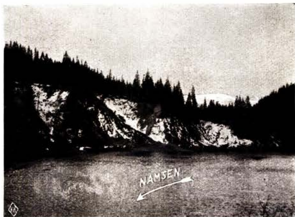
Leirmæler mot Namsen undgått ved linjeføringen gjennom Tømmeråstunnel.
