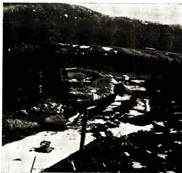
Bro over Sandøla. Karrene ferdig. Grong st. i bakgrunnen.
