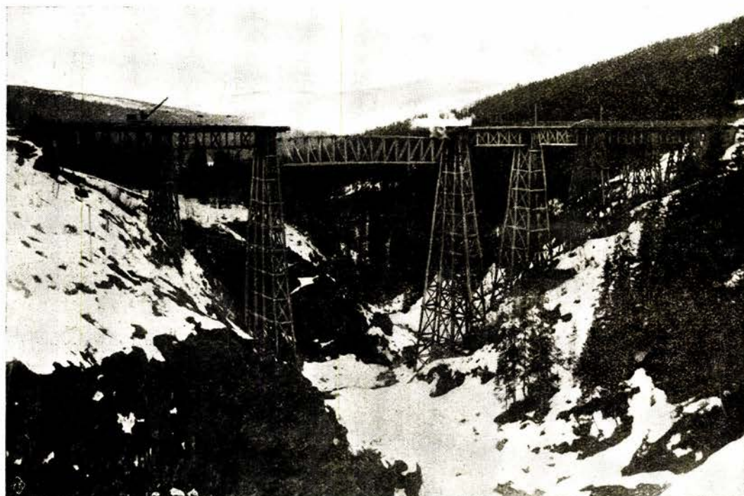
Dreia bro. Sprengning av midtspennet.
