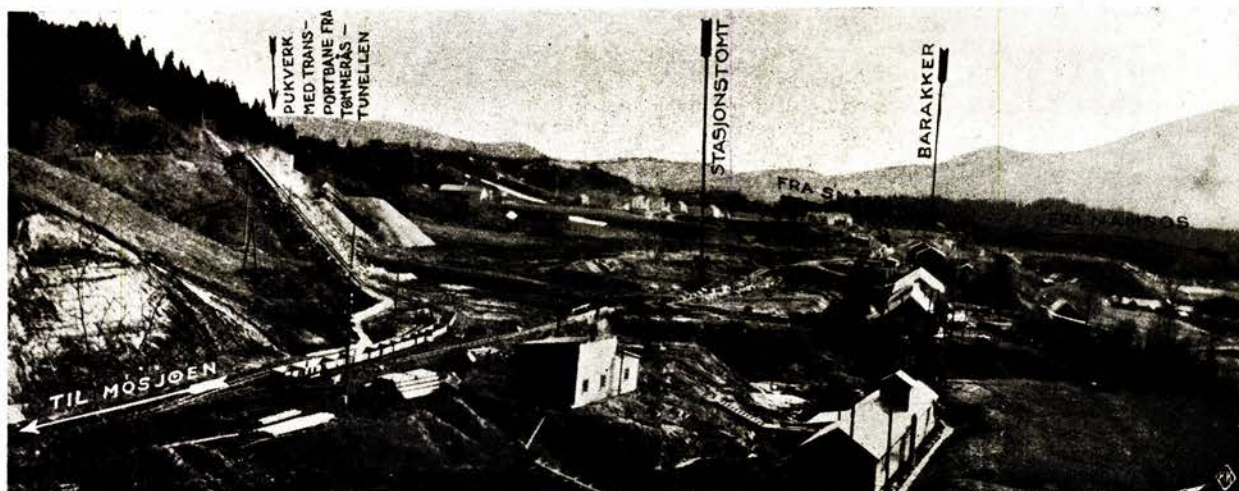
Grong delstasjon sett sydover.
