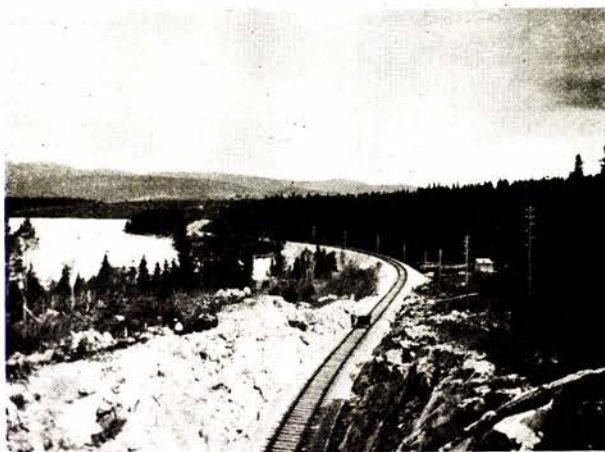
Fra tunnel II, sydfra mot Reitlo.
