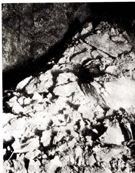
Fig. 6. Det åpne rum oppe under taket. Bildet er tatt fra et punkt nær stollåpningen i venstre vegg. Nederst sees toppen av stenrøisen som hviler på tømmeropkrysningen, øverst tilvenstre sees endel av høire sidevegg (råteveggen) og øverst tilhøire sees endel av nordre vegg. Bildet er tatt ved nyttårstid 1927.
