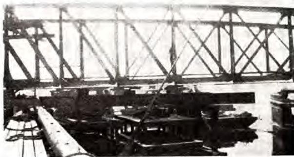
Fig. 5. Brospennet opkilet klar til sammenklinking.
