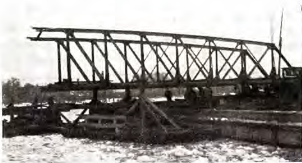
Fig. 4. Embarkering av det reparerte brospenn.
