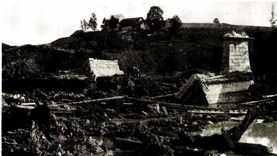
Samme situasjon i detalj som paa første fotografi. Fotografiet er tatt fra ytre kant av raset øst for linjen og viser rasveggen, det utglidde landkar, sjette pillars veltede fundament og den gjenstaaende pillar V.
