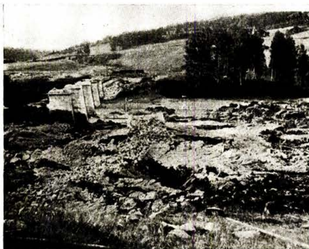
Fotografiet er tatt fra søndre elvebred øst for linjen. Man ser de utraste masser som strækker sig bortimot nordre elvebred og de gjenstaaende pillarer I til V.
