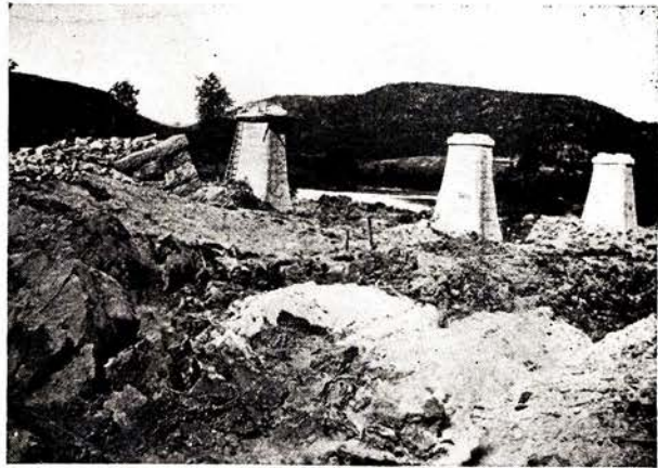
Billedet er tatt fra østsiden av raset, mere paatvers av linjen. Man ser bl. a. pillar III, IV og V samt det utraste søndre landkar mellem tilskueren og pillar V.
