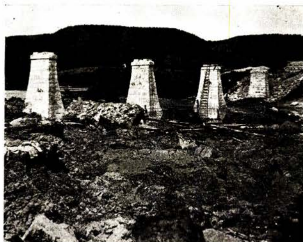
Billedet er tatt fra samme kant som tredje fotografi men litt nærmere raset. Man ser her betongklossen fra den utraste sjette pillar med bundflaten op liggende ved siden av pillar IV.
