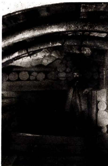
Fig. 4. Lærebuer for hvælvsbygning opsat. Man ser laftekassene opsat — længere bakover — under det parti som derefter skal fjernes og understemples. Et hul i taket er provisorisk lukket med tømmer. Bakfor venstre laftevæg — men vanskelig synlig paa billedet — er der allerede tat utvidelse for stempel 1.
