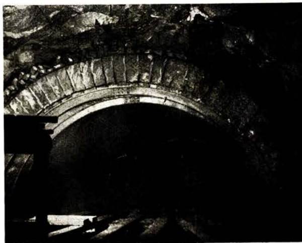
Fig. 6. Færdig 0,5 m. hvalv. Fra dette punkt stiger hvalvtykkelsen mot et parti hvor fjeldet blir borte og som følger maa rundstemples.
