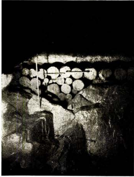
Fig. 1. Stuffen av et avsnit som er under avkiling og stimpling. Rundstimpling og understillas sees ikke paa billedet. — Man ser tykkelsen av det gjenstaaende skal av fjeldet mellem utvidet bundstoll og de løse masser over. Paa begge sider er bundstemplene, som ikke sees paa billedet, anbragt et stykke fremover og avviklingen av fjeldet paa-gaar med smaa tørringer.
