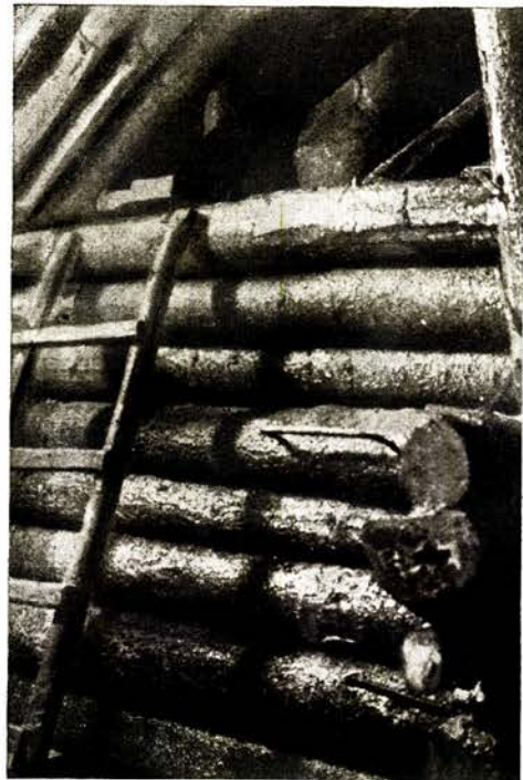
Fig. 2. Tverrvæg i laftekasse. Øverst tilvenstre paa billedet sees 3 st. av stempel 2 med paasatte 3-kant lækter.
