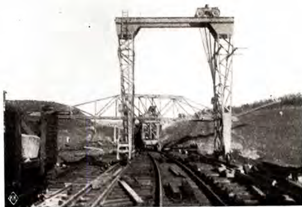
Monteringsplassen. „Rolfso-undkranen“ under svingning.
