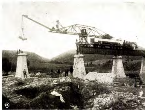
Utlekning av oplagerstener paa pillar V.
