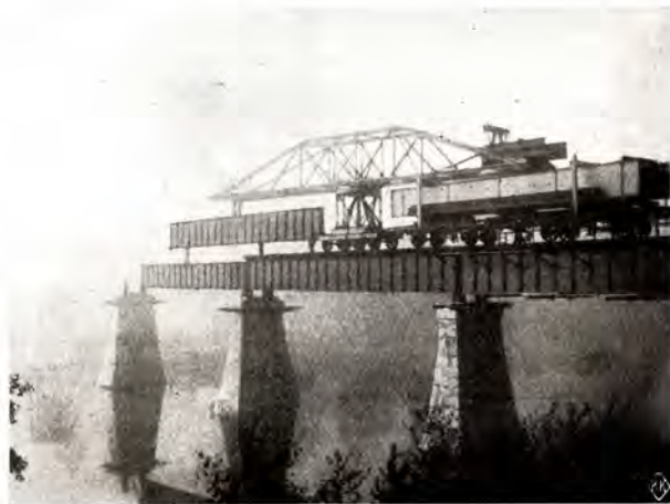
Utsiøtning av en bærevæg i 4. spænd fra nord.
