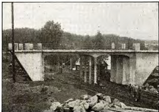
Overgangsbros av jernbeton for Norges Statsbaner ved Tangen
