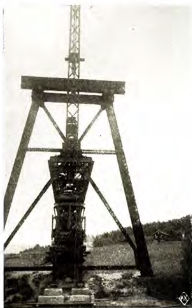
Utsætning av hjelpepillar for montering av det første 28 m spænd.
