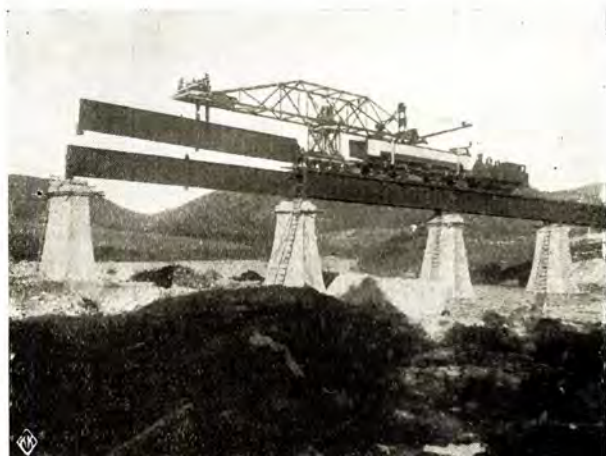
Utsætning av en bærevæg i 5. spænd.
