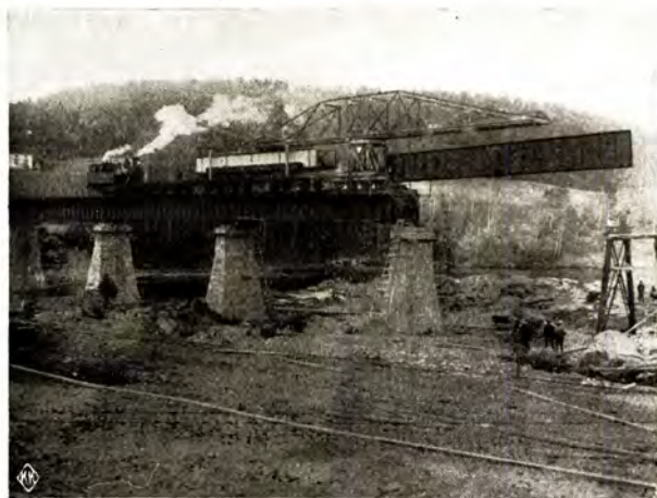
Utsætning av 2/3 av en 28 m bærevæg i 6. spænd. (Hjelpepillaren sees længst t. h.)
