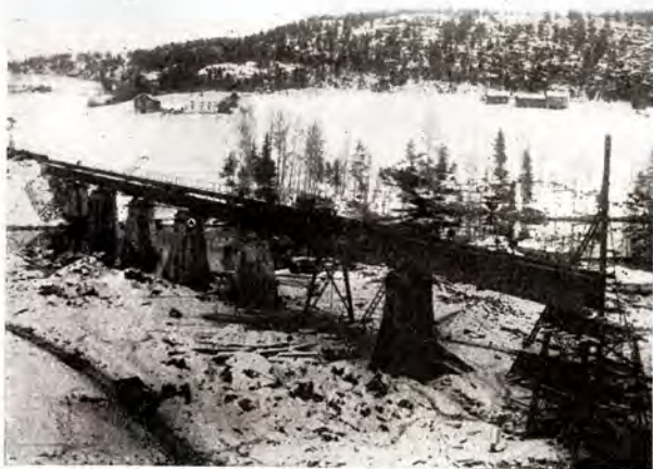
5 stkr. 20 m spænd, 1–28 m spænd og \frac{2}{3} av søndre 28 m spænd montert.
