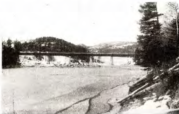
Broen færdig montert, seet fra veibroen over Østeraaen.
