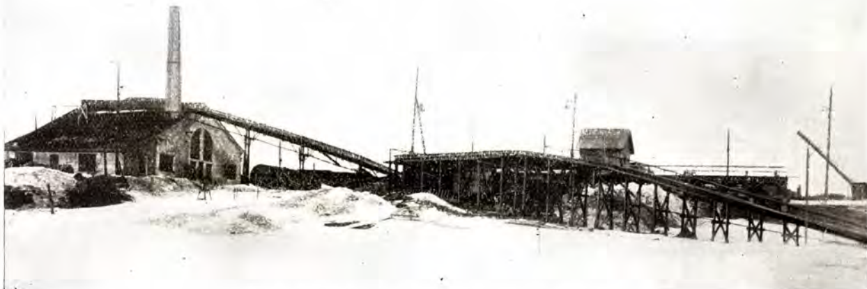
Fig. 3. Telegrafvæsenets impregneringsanstalt, Lillestrøm.
