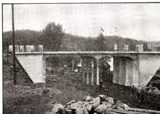
Overgangsbro av jernbeton for Norges Statsbaner ved Tangen
