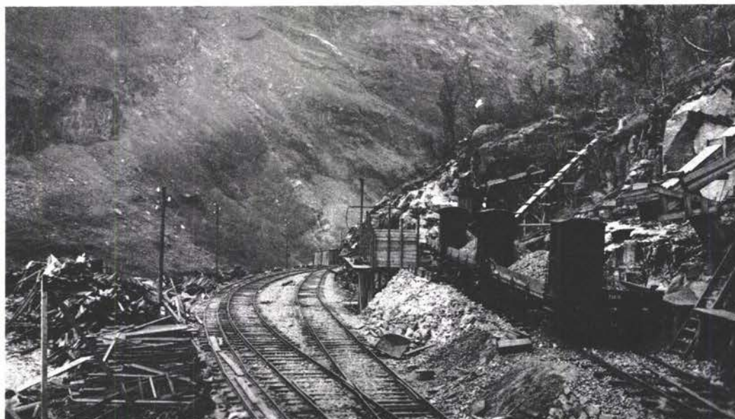
Fig. 19. Sporarrangement ved opplastning av pukk i Nåli
