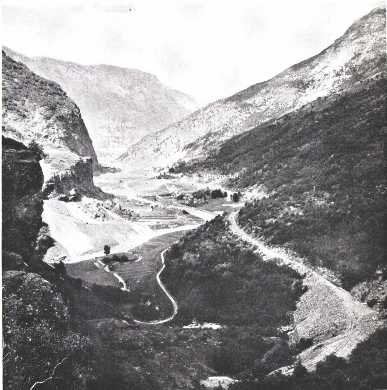
Fig. 6. Omkring Flåm kirke. Sett nordover fra Furuberget tunnel.
