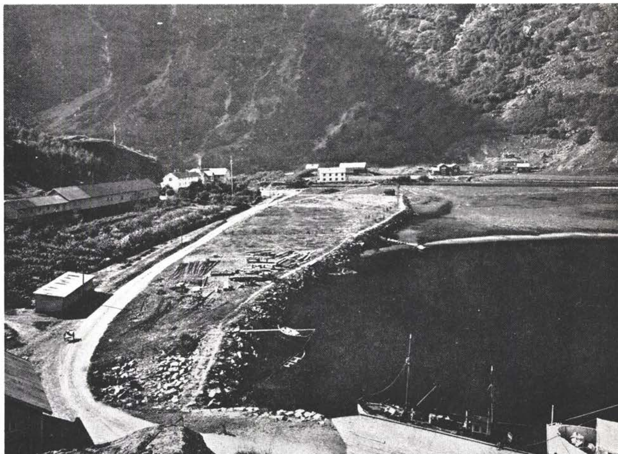
Fig. 7. Fretheim (Flåm) ved anleggets begynnelse.
