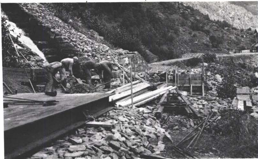
Fig. 21. Bru over Lille Reppa under arbeid.
