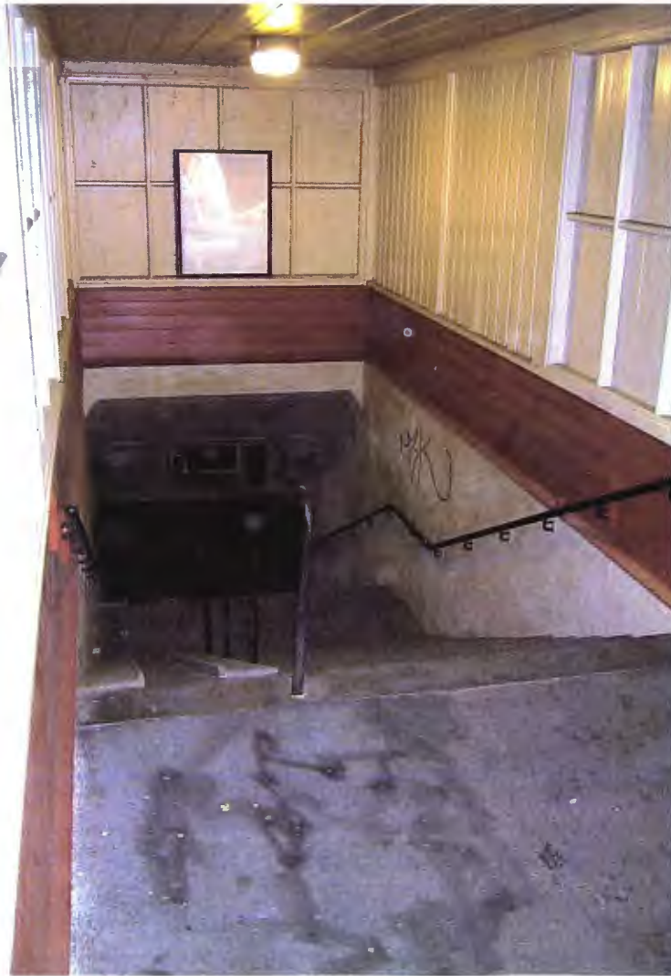
Figur 4.4, trapper ned i kulverten
