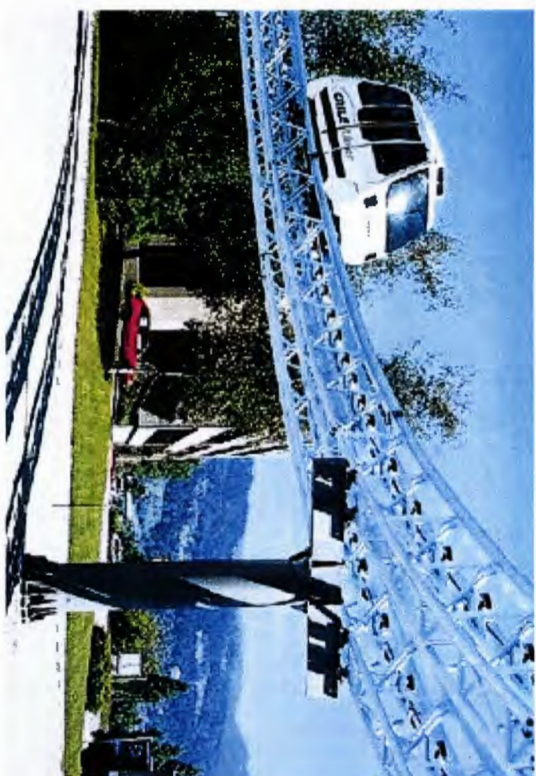
Fig. 3.2.2 Gitterdrager, søyler og bjelke, Cable Car-systemet.
