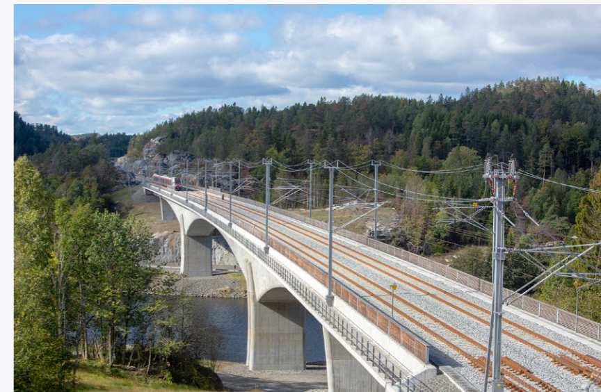
Hallevatnetbrua, utanfor Larvik, er 424 meter lang og er den lengste av ti bruer som er bygd mellom Larvik og Porsgrunn.
