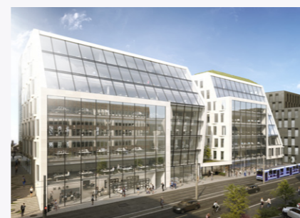
Omlag 1 500 av medarbeidarane i Bane NOR flyttar inn i det nye hovudkontoret våren 2019. Ein del medarbeidarar skal framleis ha kontor plass i Posthuset.
