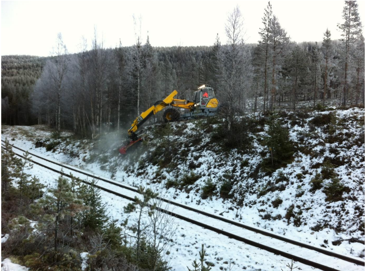
Vegetasjonsrydding langs Rørosbanen.
