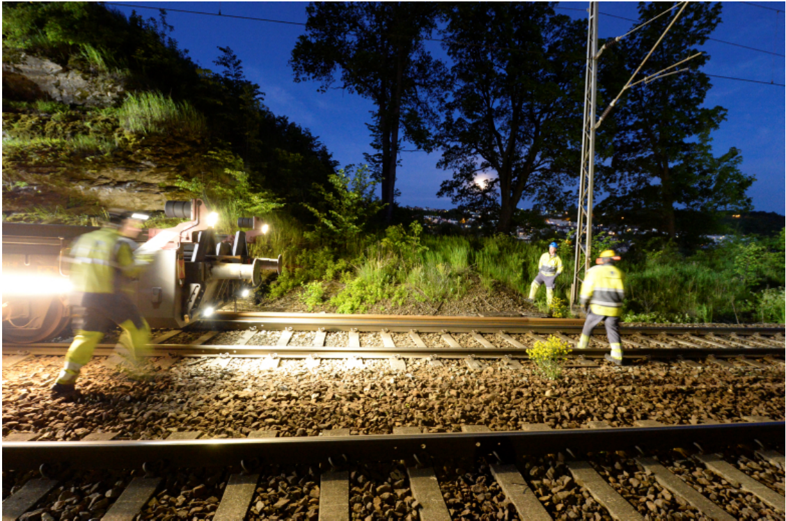
Fra kveldsarbeidet med skinnebytte i Brynsbakken. Foto Øystein Grue
