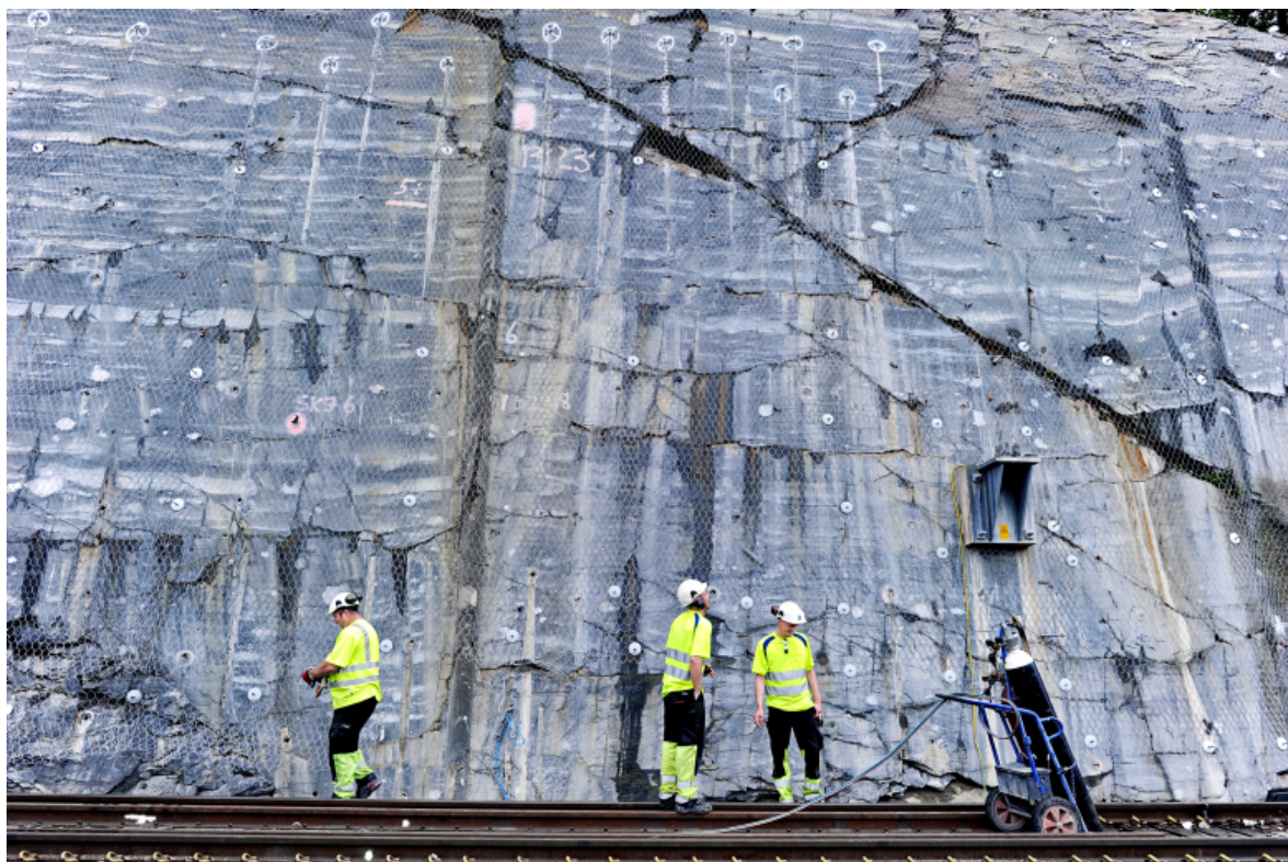
Fjellsikring. Foto: Bane NOR
