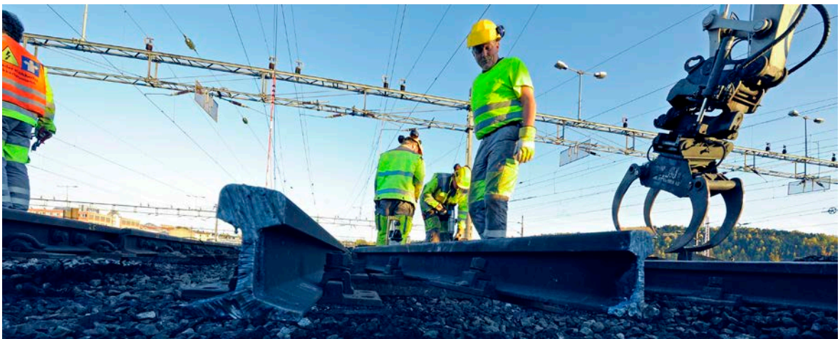
Her arbeides det med en ny sporveksel ved Oslo S. Foto: Bane NOR
