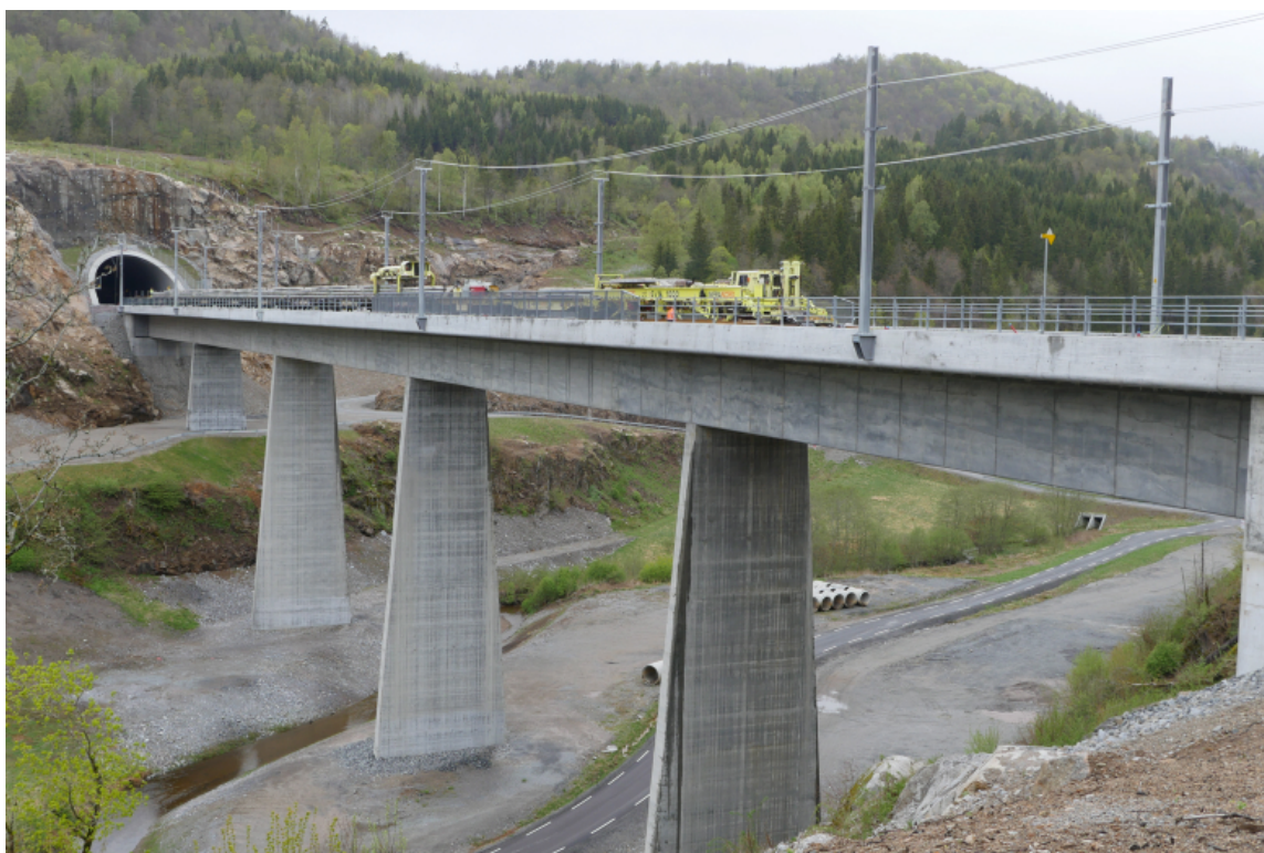
En av mange broer på Farriseide - Porsgrunnprosjektet, som åpner denne høsten for togtrafikk. Foto: Bane NOR
