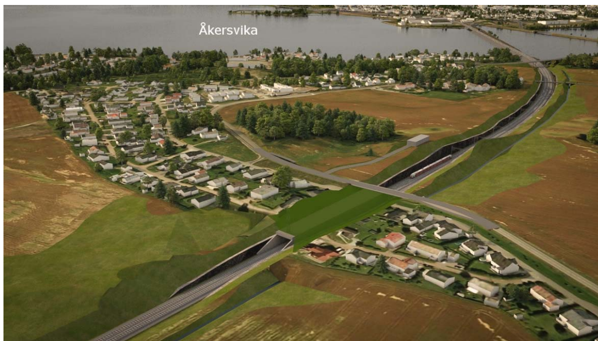
Figur 6-5 Bekkelaget, kulvert, alternativ K1 vest-2b. 2 spor inn i kulvert fra sør og 3 spor i nordenden av foreslått kulvert (125 m)
