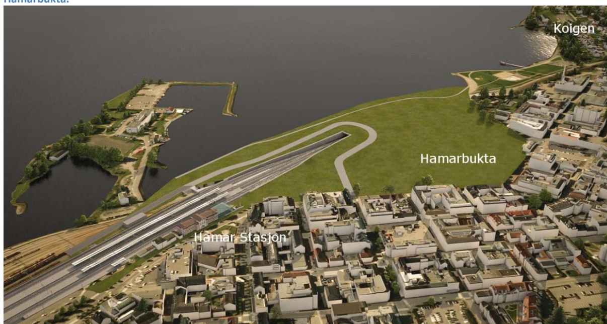
Figur 4-9 Kulvert under Hamarbukt sett mot nordvest, alt. K1 vest-3b. I dette tiltaket er det forutsatt oppfylling av Hamarbukta.
