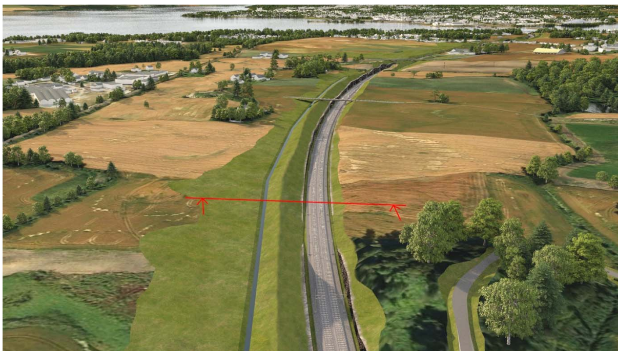
Figur 6-12 Utklipp bilde viser markering ved snitt km 121,000
