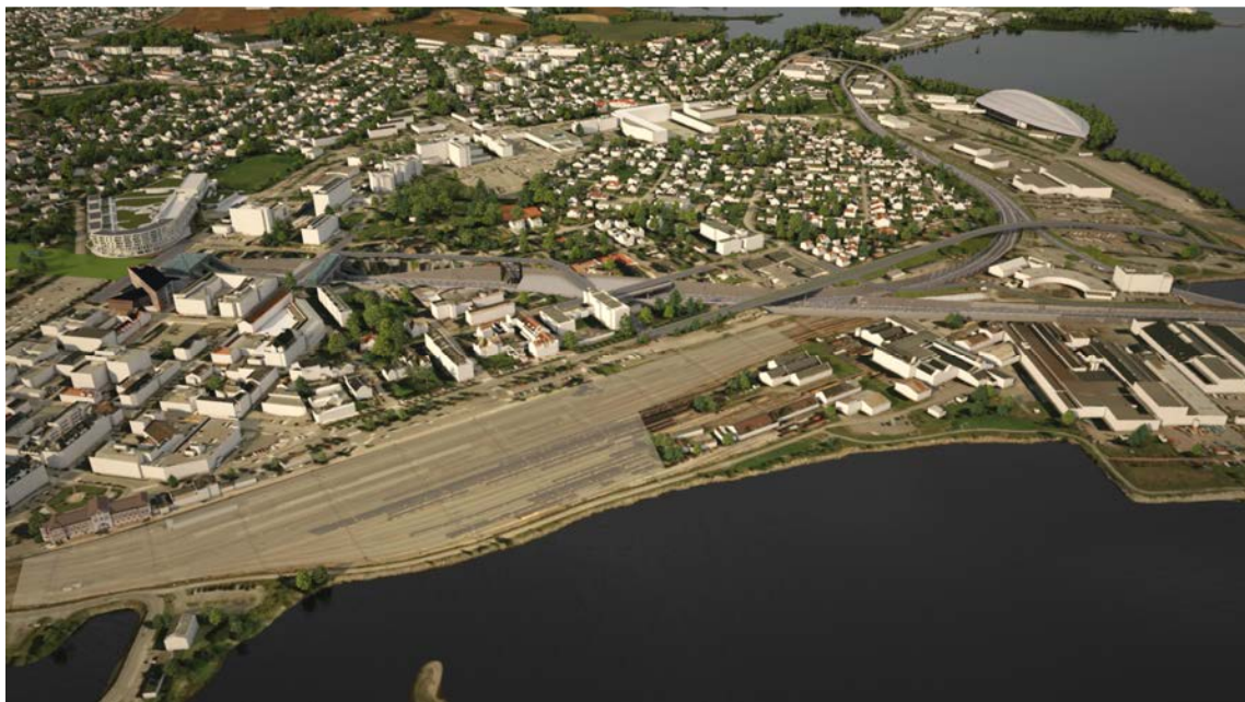
Figur 5-48. Variant K2 midt-MELLOM lakk toner bruddet i landformen noe ned, men tiltaket fremstår fremdeles som et betydelig kutt gjennom Østbyen. Som for hovedalternativet vil fjerning av eksisterende jernbaneanlegg åpne opp for en visuell og funksjonell kontakt mellom byen og Mjøsa med omland.
