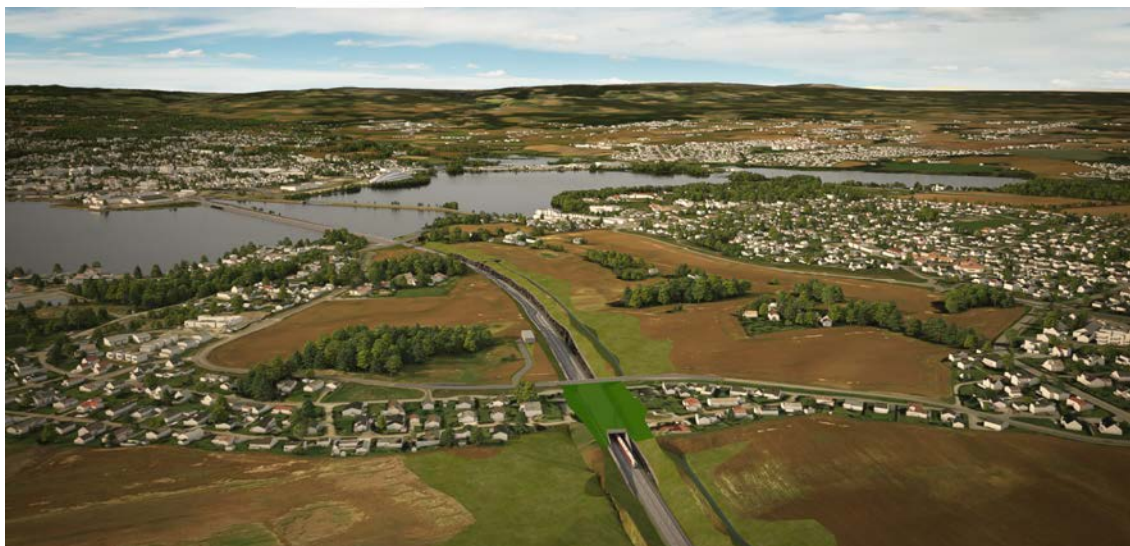
Figur 5-14. Bekkelaget boligområde som omkranser jordbruksområdet Tokstad-Gyrud. Det nye dobbeltsporet for alternativ 2a føres i skjæring og splitter bebyggelsen sør i delområdet. Kulvert etableres imidlertid der bebyggelsen splittes og bidrar til å redusere omfanget av tiltaket. Standpunkt 239 meter over terreng.
