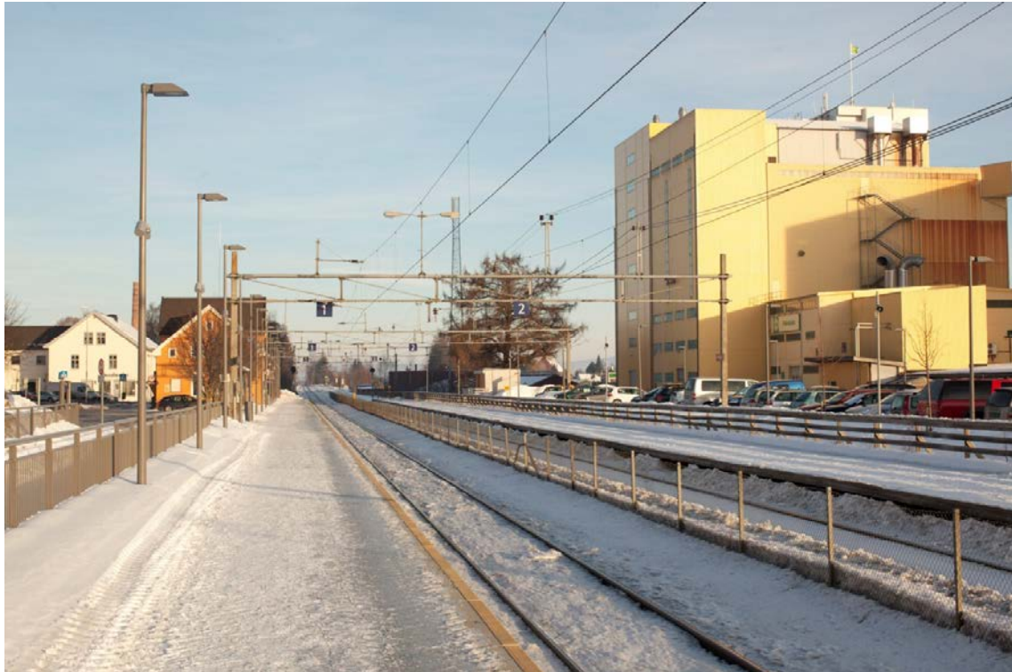
Figur 5-5. Stange stasjon. Kornsiloen til høyre i bildet er i stor grad med på å prege stasjonsområdet. Foto: Marius Fiskevold
