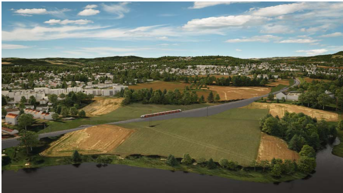
Figur 5-86. Ved alternativ K3 øst-3 stasjon ved Vikingskipet vil tiltaket innebære KL-master som utgjør et fremmed element. I tillegg vil store fyllinger og skjæringer bryte med skalaforholdene og landformen på Børstad, men av størst betydning er fragmenteringen av det avgrensede landskapsrommet. Standpunkt 91 meter over terreng.
