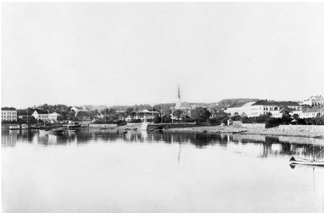
Figur 4-4. Hamarbukta før jernbaneutbyggingen, udatert. Foto: Domkirkeoddens fotoarkiv.
