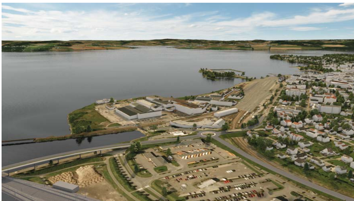
Figur 5-38. Alternativ K3 øst-3 stasjon ved Vikingskipet innebærer fjerning av eksisterende jernbaneanlegg som åpner for en visuell og funksjonell kontakt mellom byen og Mjøsa med omland tilsvarende korridor 2, men uten en ytterligere fragmentering av delområdet Espern.
