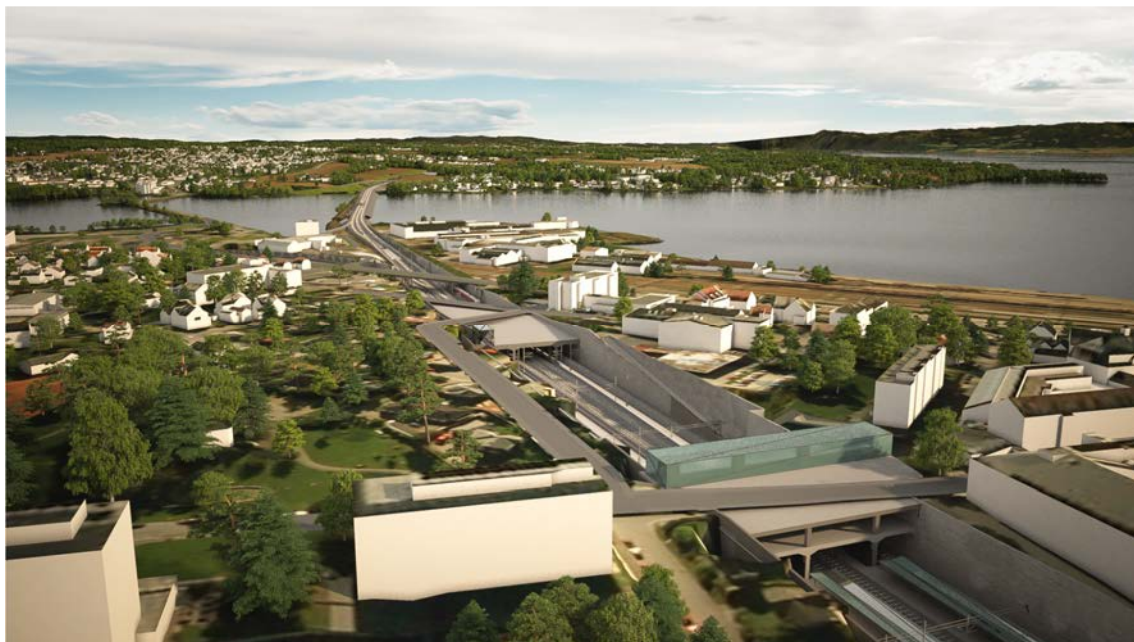
Figur 5-53. På grunn av parklokkets avgrensede utstrekning vil fortsatt variant K2 midt-1a MELLOM lokk fremstå som en sjakt omkring stasjonsområdet.
