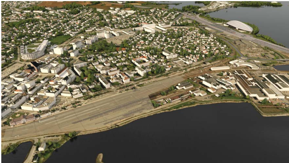
Figur 5-49. Alternativet K3 vest-3b stasjon ved Vikingskipet berører ikke delområdet direkte, men fjerning av eksisterende jernbaneanlegg åpner opp for en visuell og funksjonell kontakt mellom byen og Mjøsa med omland. Byutvikling som følge av tiltaket kan på sin side medføre redusert utsyn fra Briskebyen mot landskapsrommet Åkersvika.
