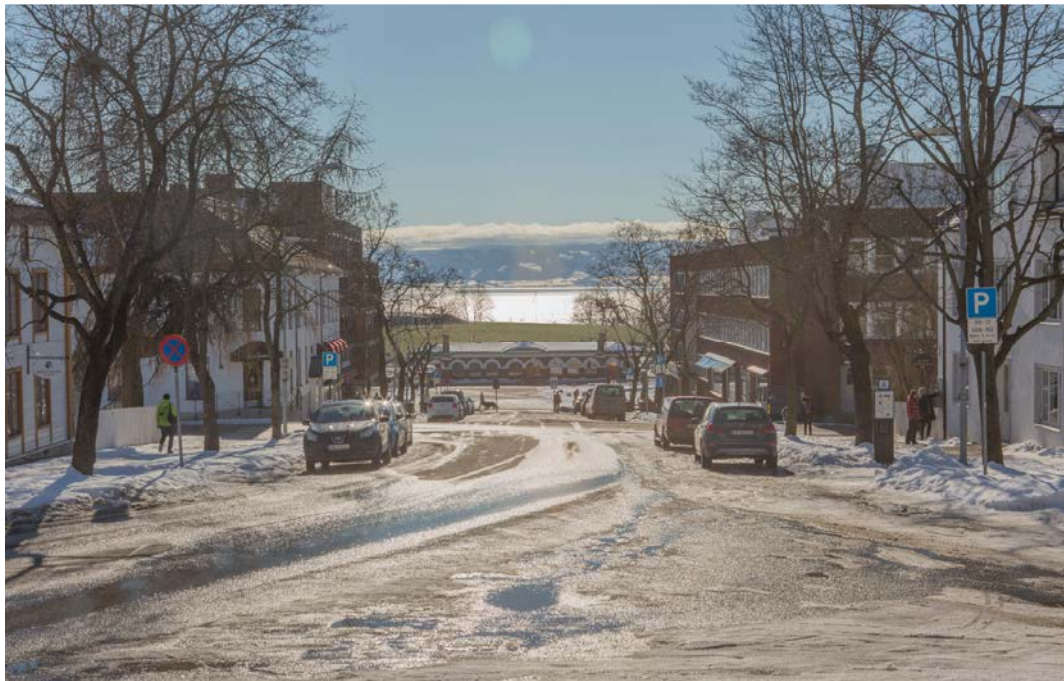
Figur 5-76. Det nye dobbeltsporet vil ikke være synlig i kirkeaksen (Kirkegata) ved alternativ K1 vest-3b dagens stasjon med kulvert under Hamarbukta, men fyllingen som jernbanekulverten ligger i vil være visuelt fremtredende i bakkant av Basaren. Således svekkes den visuelle forbindelsen mellom området omkring kirken og Mjøsa.
