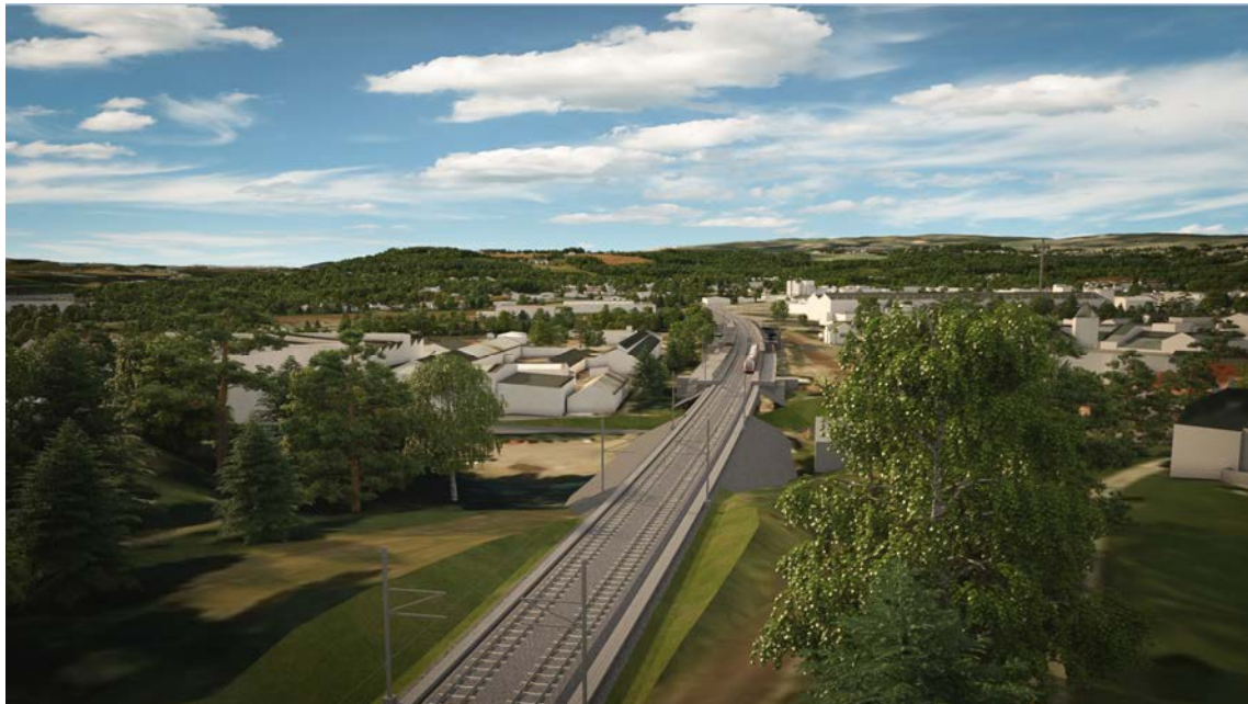
Figur 5-103. Atkomsten til Brumunddal stasjon sørfra er hevet over dagens spornivå, men anlagt i samme trasé. Tiltaket influerer landskapsbildet i liten grad. Standpunkt 22 meter over terreng.
