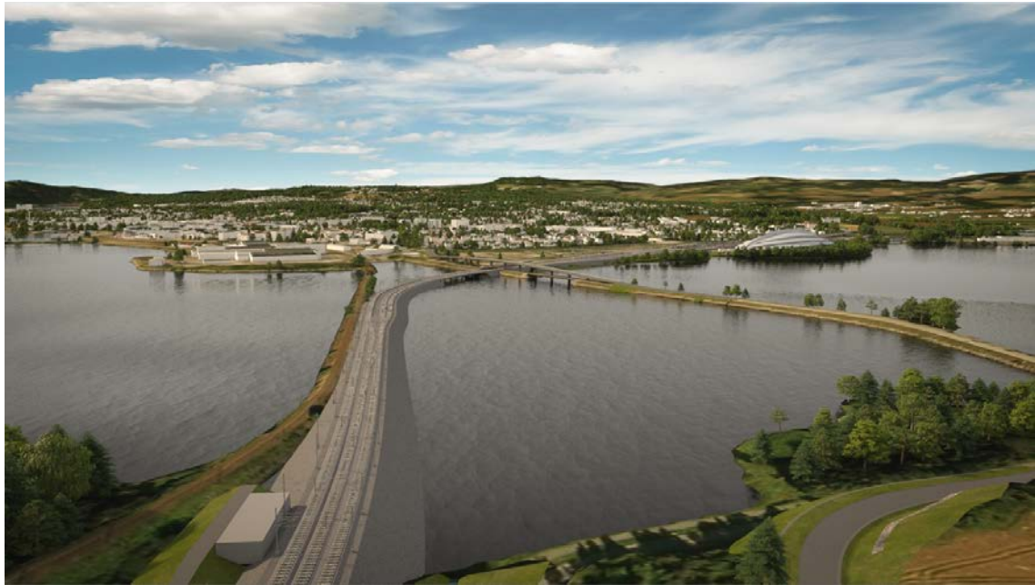
Figur 5-21. Illustrasjonen viser alternativ K3 øst-3 stasjon ved Vikingskipet med linjeføring på innsiden av eksisterende spor. Fyllingen er både høyere og bredere enn dagens situasjon, og den visuelle barrieren som jernbaneanlegget over Åkersvika utgjør i dag vil dermed forsterkes noe. Standpunkt 67 meter over terreng.
