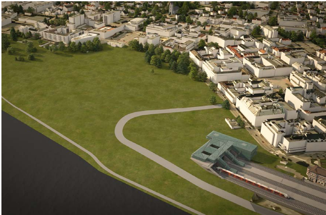
Figur 5-71. Varianten K1 vest-3b MAKS kulvert har en fullt overdekket kulvert kan skape en bedre fysisk forbindelse mellom byen og vannet. Den overdekte kulverten vil skape en betydelig visuell barriere på grunn av det forlengede kulverttaket som hever seg inntil omkring 10 meter over dagens terreng.
