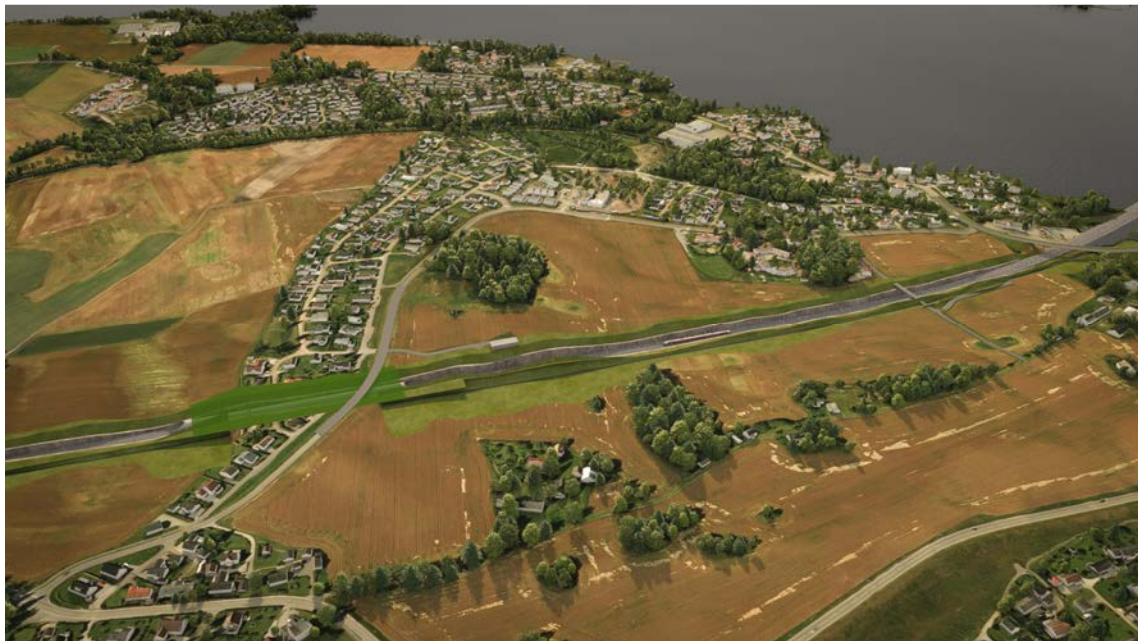
Figur 5-11. Det nye dobbeltsporet for variant 56-1a Ottestad-Åkersvika ligger i randsonen til mer sårbare områder rundt gårdene Tokstad og Gyrud og skjærer mer sentralt gjennom det avgrensede jordbruksområdet. Standpunkt 180 meter over terreng.
