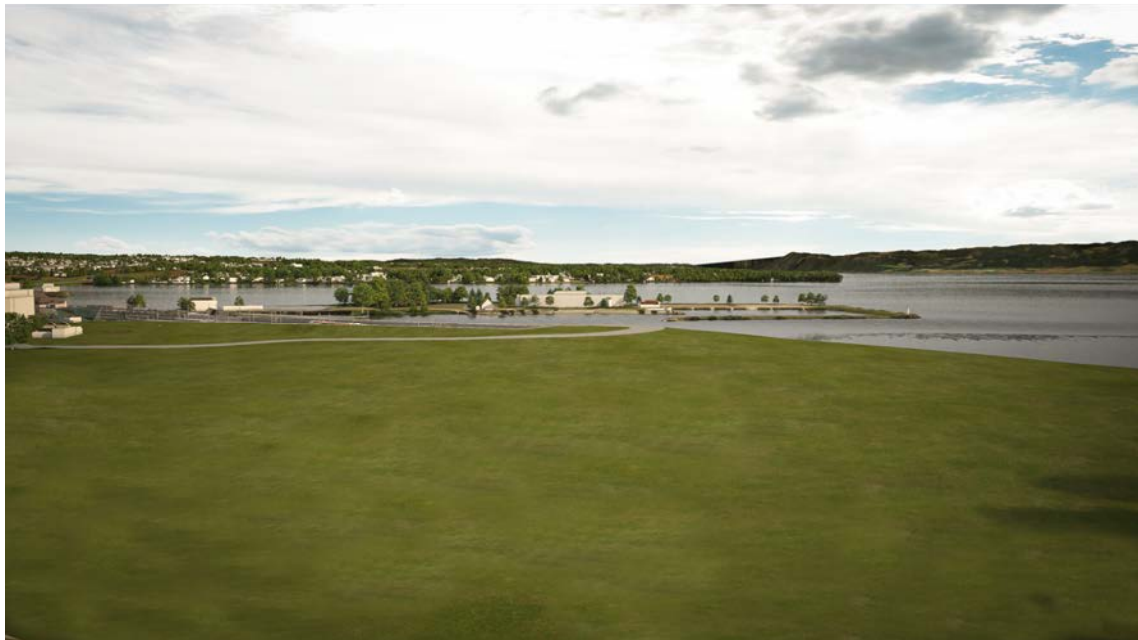
Figur 5-72. For alternativ K1 vest-3b dagens stasjon med kulvert under Hamarbukta ligger det nye dobbeltsporet i overdekket kulvert i deler av krysningen. Dermed forsterkes den funksjonelle forbindelsen mellom byen og Mjøsa, men strandlinjen forskyves. Terrenget heves stedvis frem mot Mjøsa, og høyden på fyllingen over kulverten og den visuelle barrierevirkningen som fyllingen innebærer varierer.
