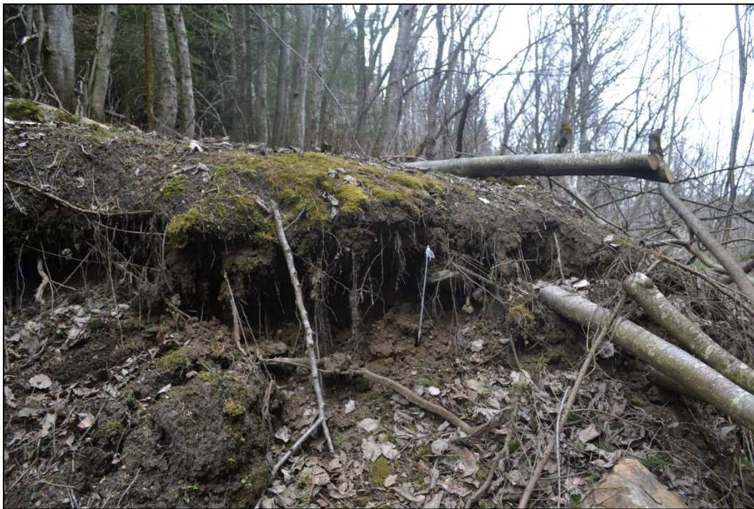
Figur 70: Overheng, høyre skråningsside (Økland, 03.05.2016)
