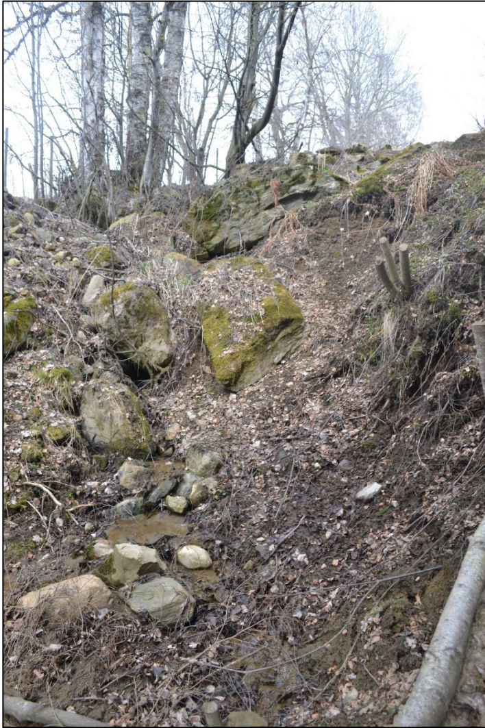
Figur 90: Ravinens knekkpunkt, deler av stokkdam 1 kan skimtes til høyre i bildet (Økland, 03.05.2016)
