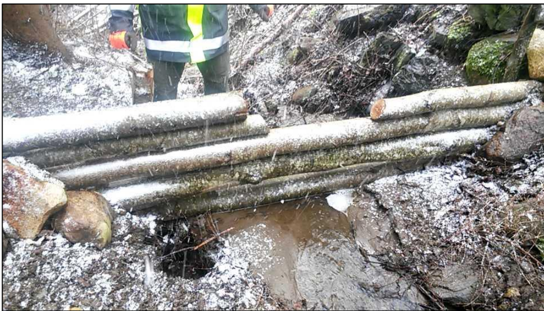
Figur 79: Erosjonshull, stokkdam 1 (høyre side) (Økland, 23.04.2015)
