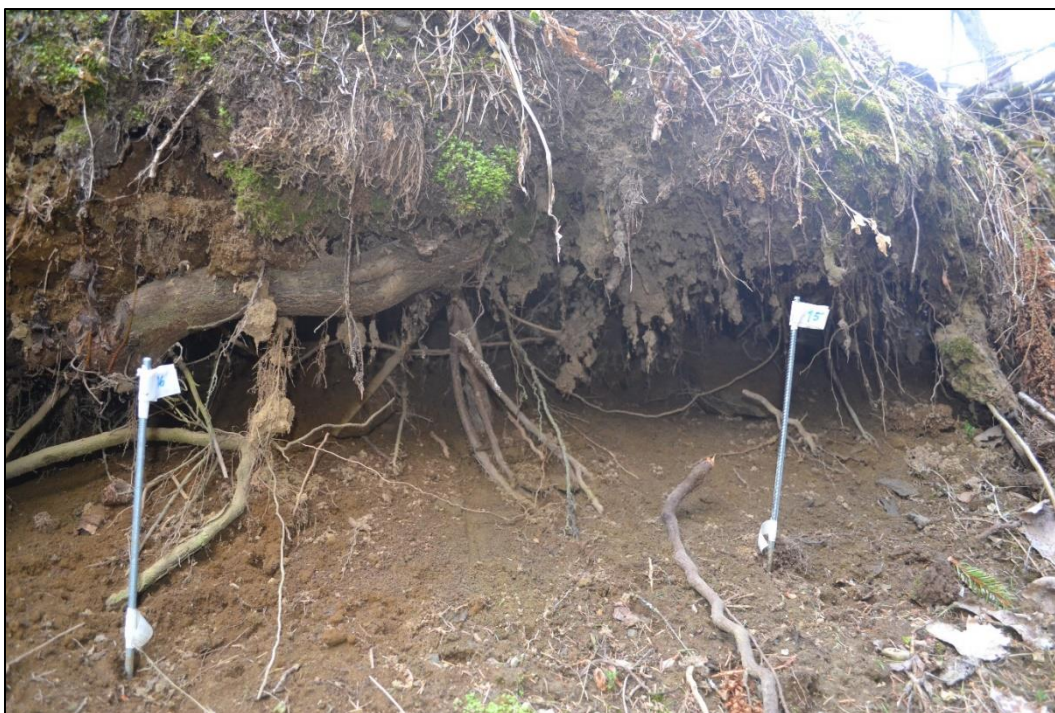
Figur 94: Eksempel på underkutting, venstre skråningsside (Økland, 03.05.2016)
