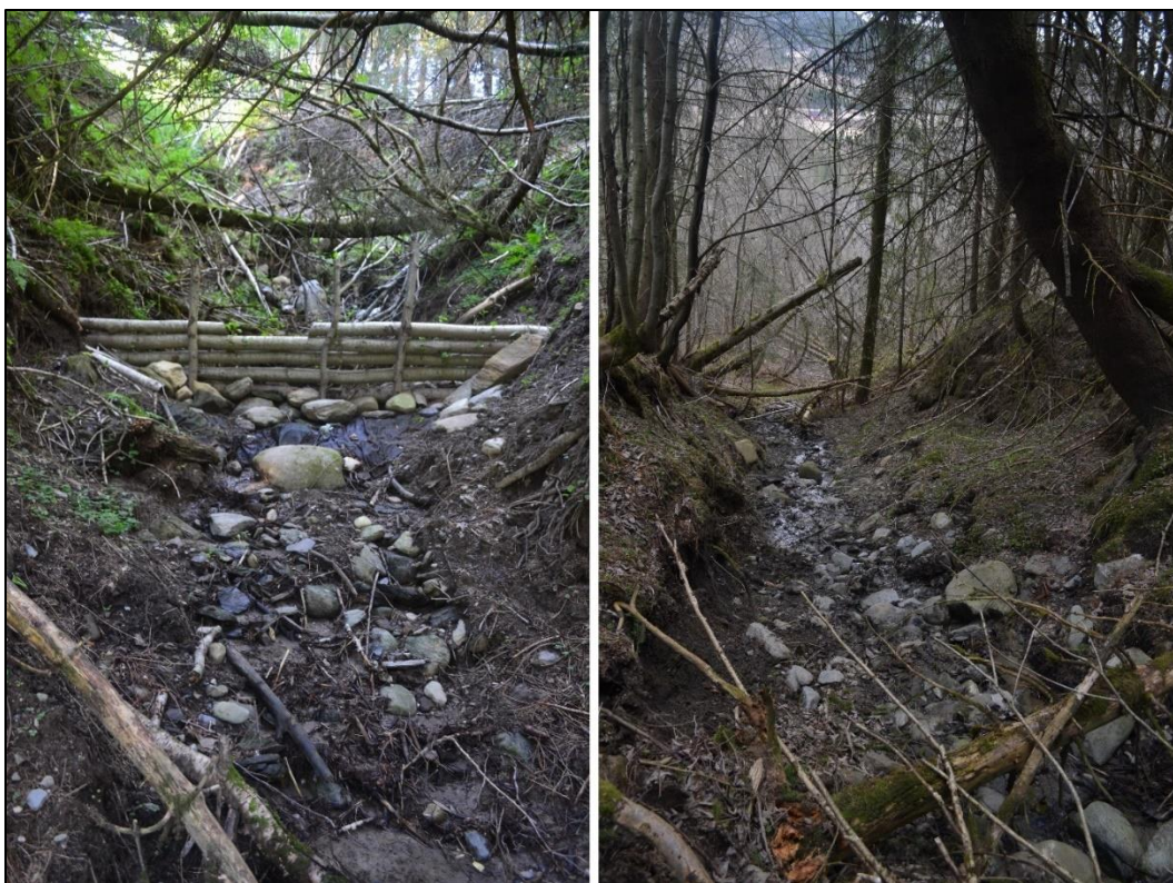
Figur 9: Grovblokket morene i bekkens nivå, nedenfor stokkdam 4 (Økland, 03.05.2016)
