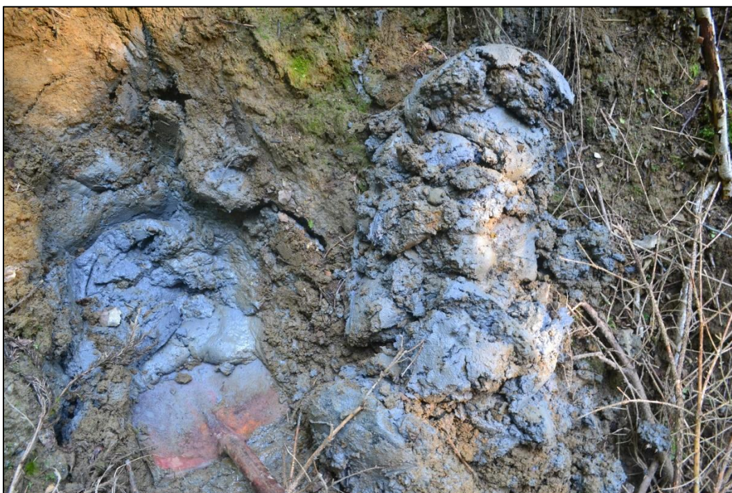
Figur 98: Graveprøve, høyre skråningsside. Høy andel silt. (Økland, 11.09.2015)
