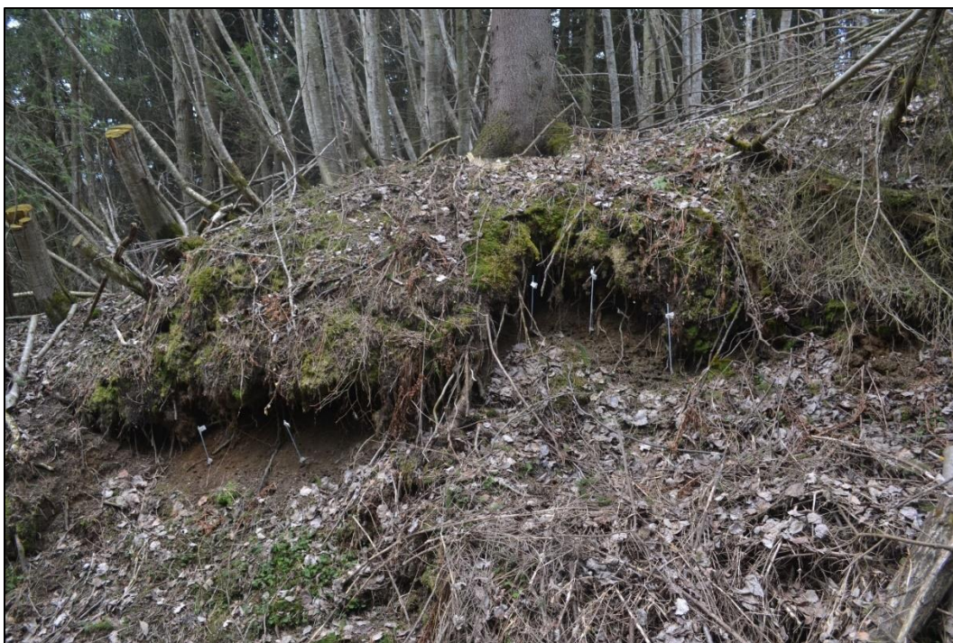
Figur 71: Overheng, venstre skråningsside (Økland, 03.05.2016)
