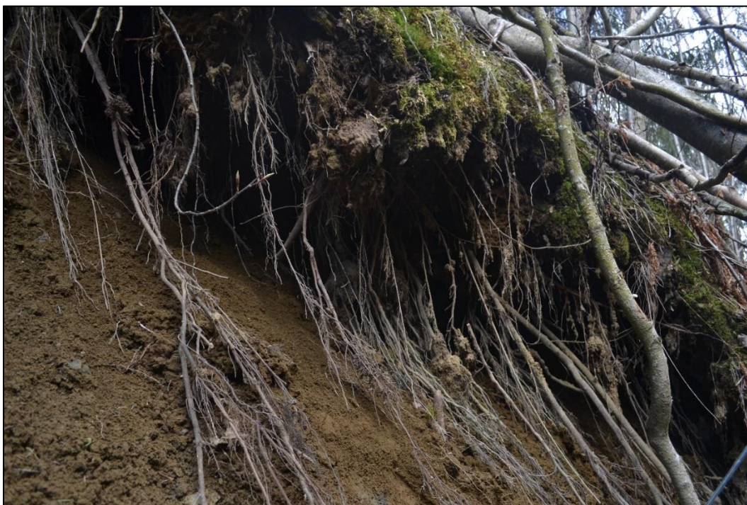
Figur 95: Underkutting og porøse løsmasser, høyre skråningsside (Økland, 03.05.2016)
