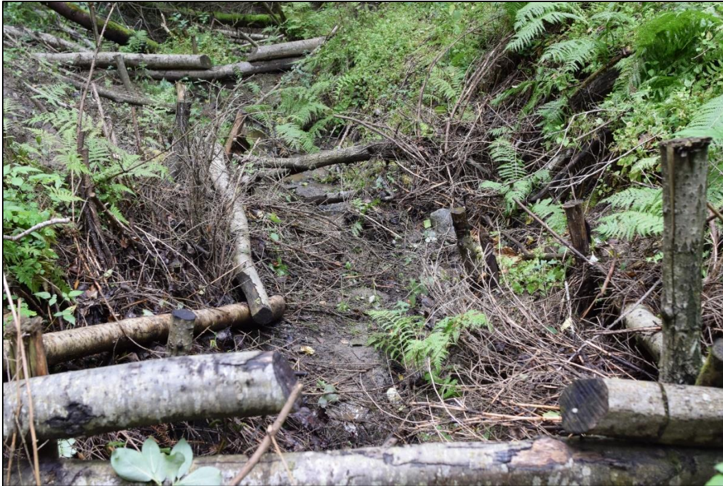
Figur 106: Kvister mellom stokkdam 2 og 3, som et ekstra tiltak for å hindre erosjon (Økland, 29.08.2016)
