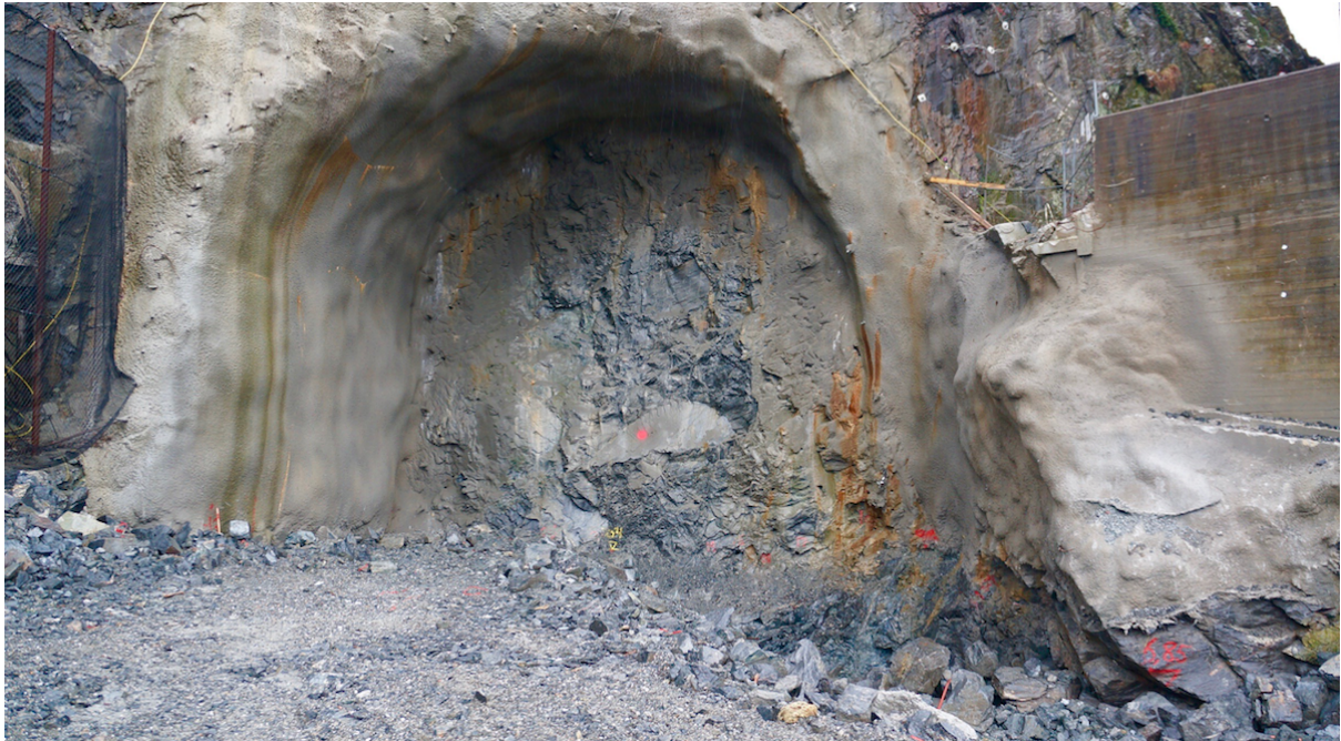
Figur 5.2: Q-verdi 1 ble estimert til høyre for påhugget, nede til venstre i bildet.
