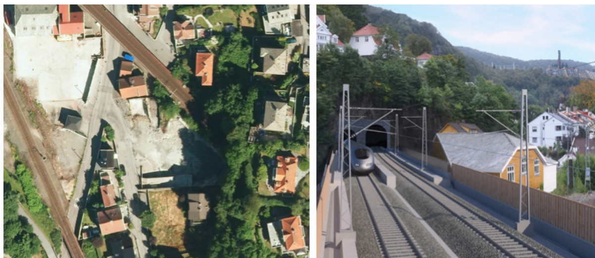
Figur 4.7: Satellittbilde av påhugget ved Fløen til venstre (utklipp fra www.gulesider.no ) og bilde som illustrerer overdekningen ved påhugget til høyre (Sve, 2016).
