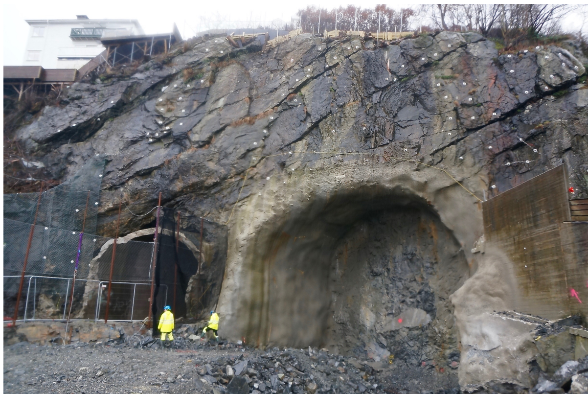
Figur 4.3: Avstandsbilde av mylonittgneisen tatt på befaring til Fløen.
