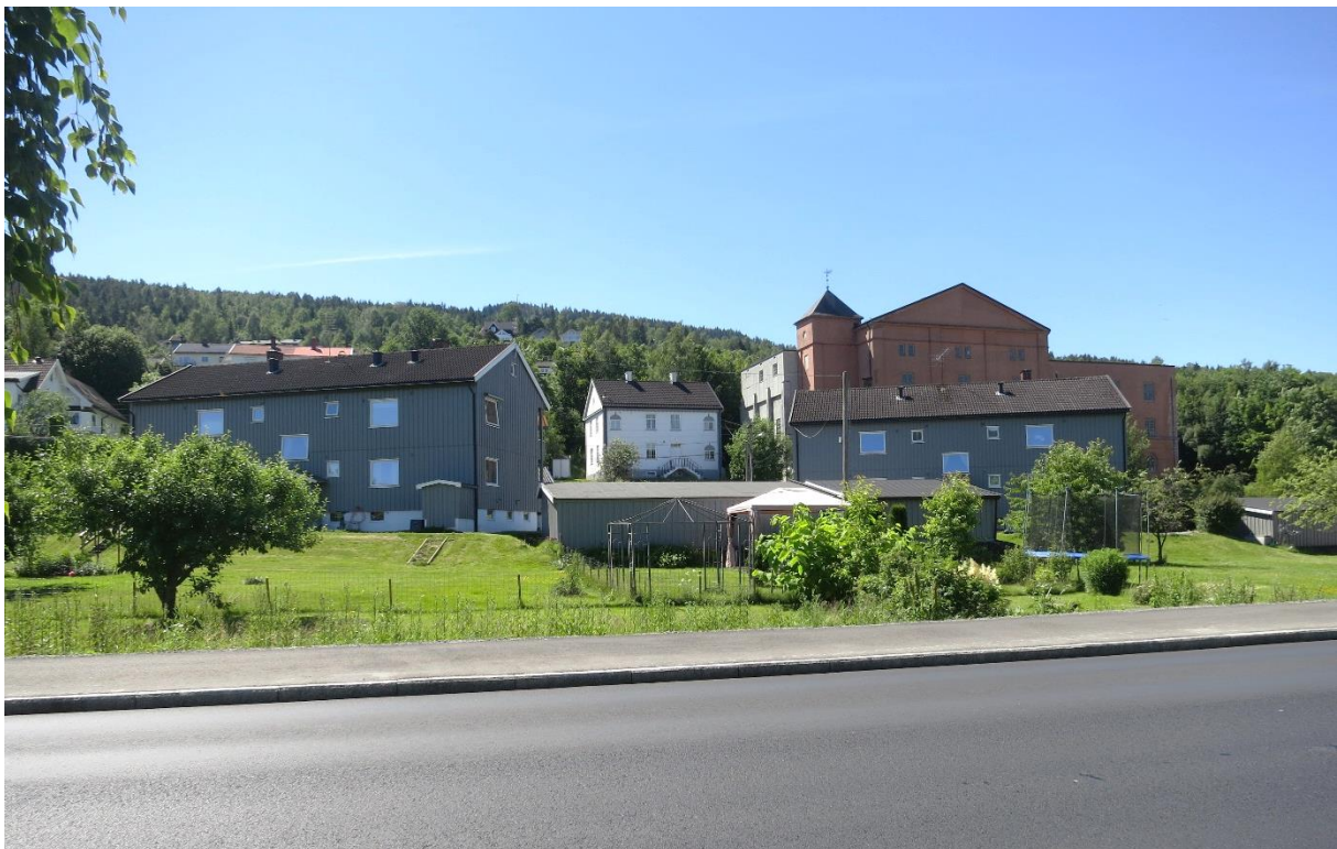
Figur 4-9: Transformatorstasjonen på Sundland står i kontrast til svenskehusene langs Professor Smiths allé og småhusbebyggelsen for øvrig i foten av Strømsåsen. Området vil bli betydelig påvirket av inngrep i alternativ Sundland vest. Foto: Einar Berg, Norconsult.
