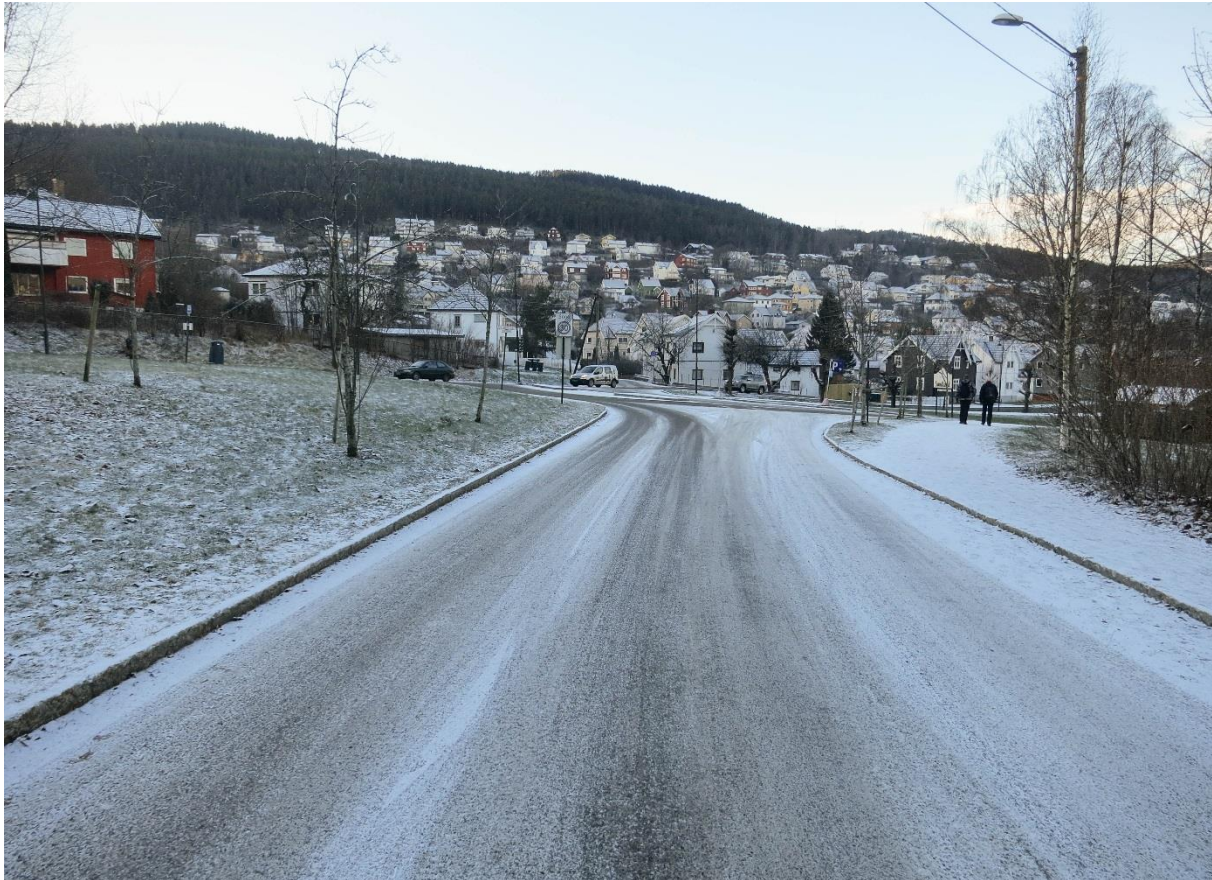
Figur 4-7: Deler av den kompakte villabebyggelsen sør for Sundland kan bli påvirket av inngrep i korridor Sundland øst. Foto: Einar Berg, Norconsult.
