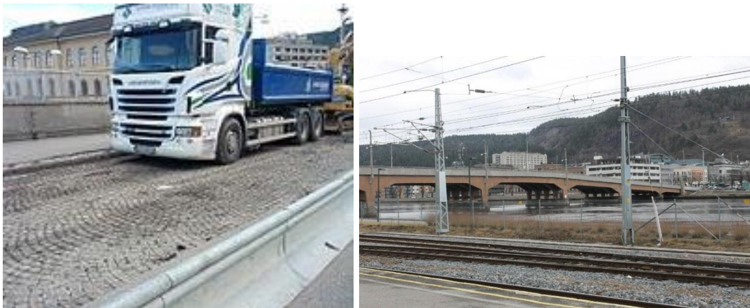
Figur 12. Bybrua. Den opprinnelige brusteinen kom fram under opprustningen i 2012. Asfaltert i dag. Foto Norconsult 2015 (Foto fra 2012 fra Wikipedia)
