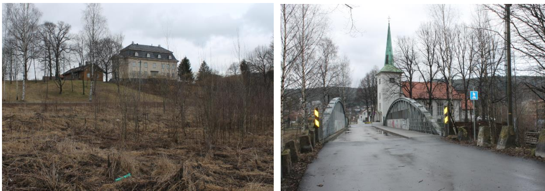
Figur 15. Smithestrøm lystgårdsanlegg og Strømsgodset kirke med den tidligere jernbanebroen i forgrunnen. Foto Norconsult 2015
