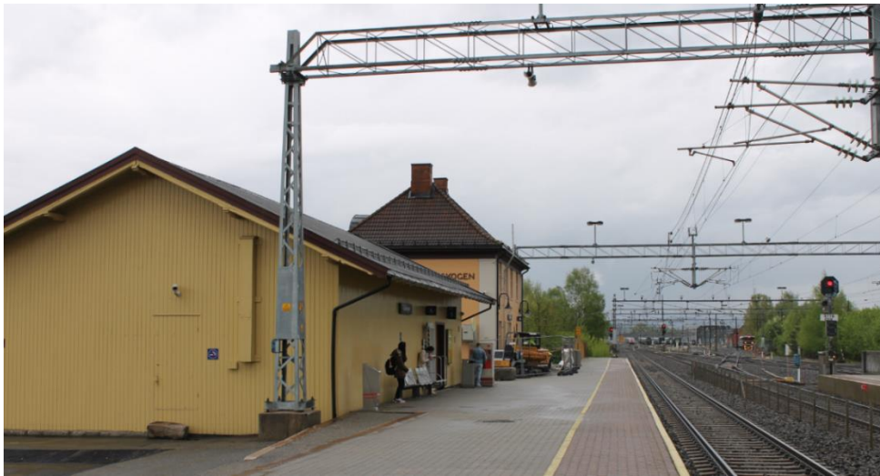
Figur 13. Gulsbogen stasjon med sykkelhotellet. Foto Norconsult 2015
