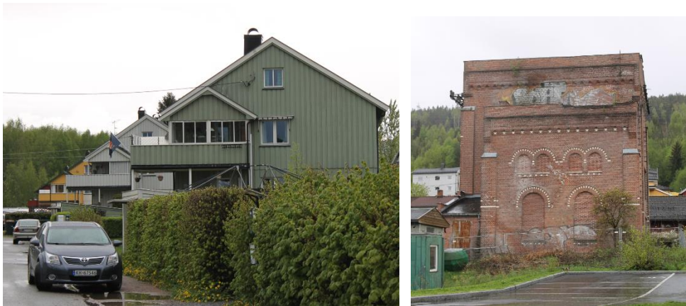
Figur 19. Boliger i Oscar Wistingsgate og trafoen fra 1910. Foto Norconsult 2015
