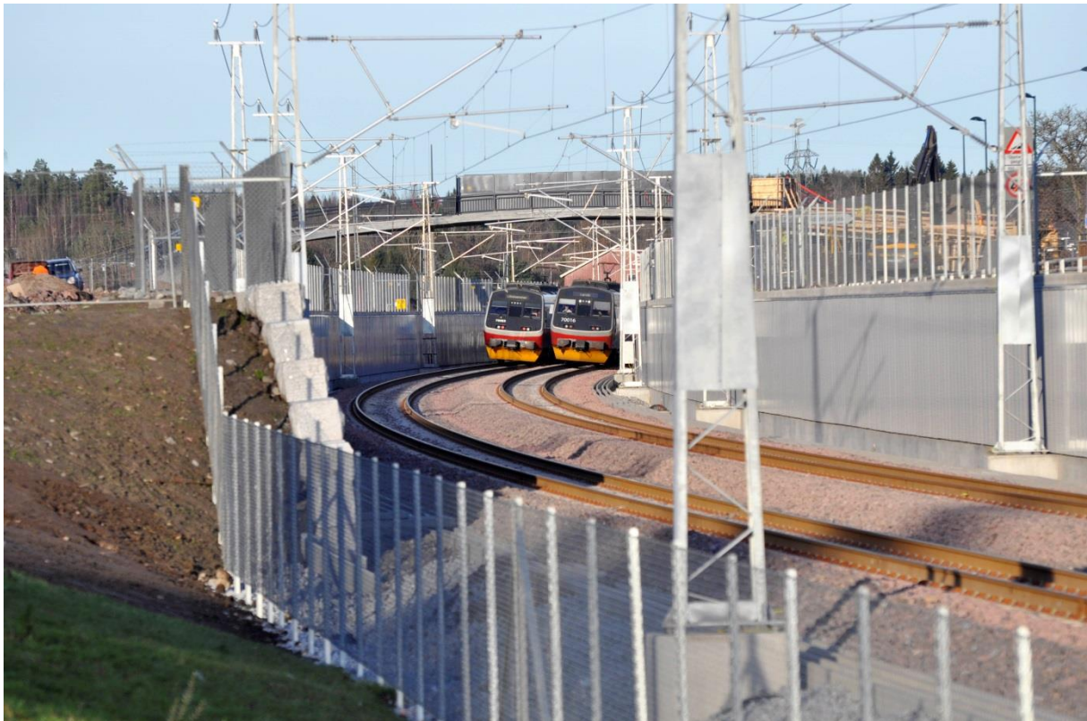
Figur 7 Dobbeltsporet i Sande, eksempel nedsenket løsning
