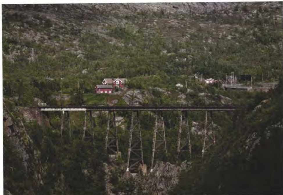
Norddalsbrua ble tatt i bruk da Ofotbanen ble åpnet i 1902 og var i bruk helt til 1988.
