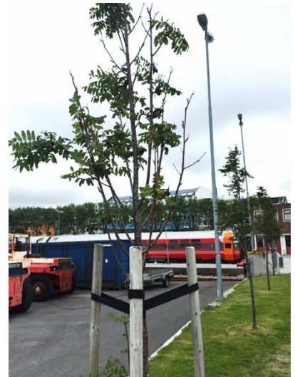
Bilde 4.4: Greindød på villrogn ( S. aucuparia ), på Bodø stasjon. Foto: Martin Dalehaug
