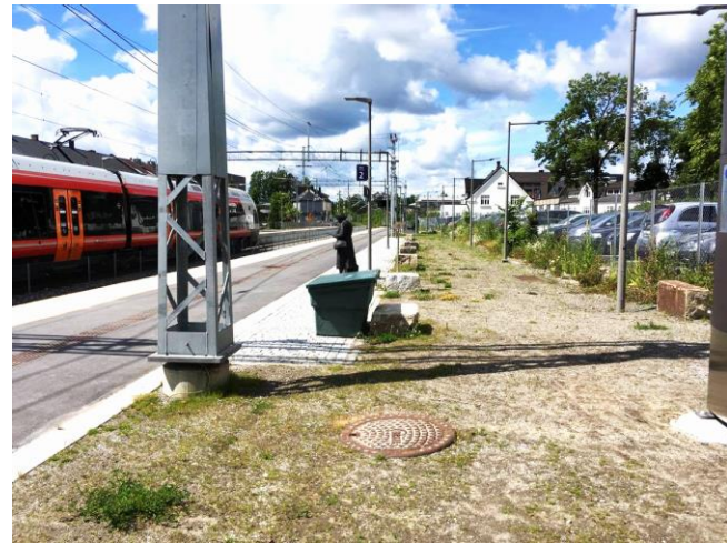
Bilde 4.36: Et av flere tilfeller på stasjonen som er dårlig utnyttet. Tilvekst av ugress langs gjerde og enkelte steder på grusdekke. Foto: Anne Norveel Semb
