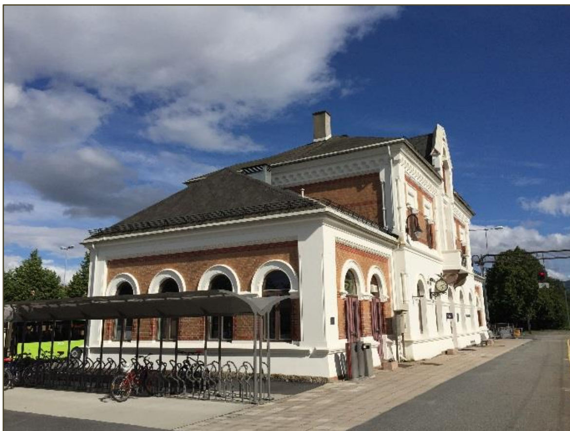
Figur 4: Hokksund stasjon er fredet i henhold til kulturminneloven. Foto: Norconsult.
